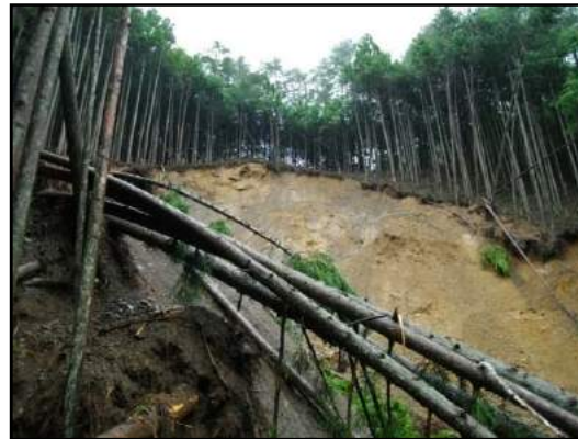
施工前の状況 (村道上部)
