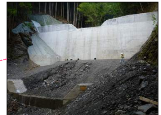
第2号谷止工 完成状況
