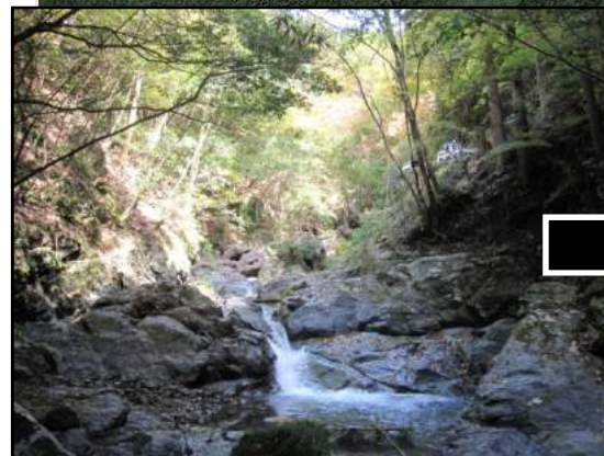
第1号谷止 施工前の状況
