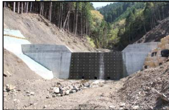
第4号谷止工完成状況
