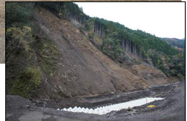
護岸工 施工状況
