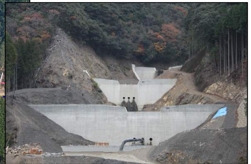
第1号谷止工 施工状況
