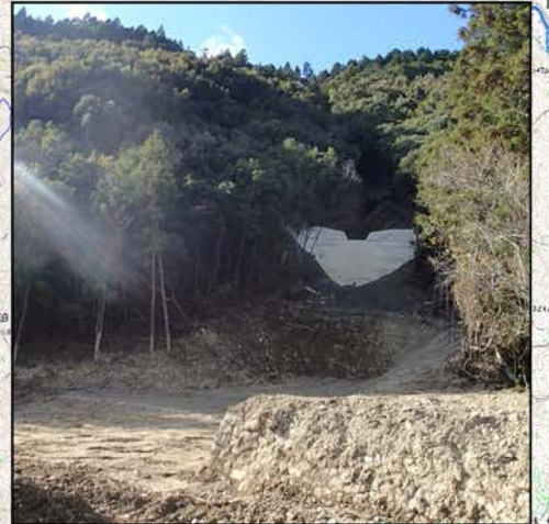
完成状況⑤(新宮市熊野川町九重和田)
