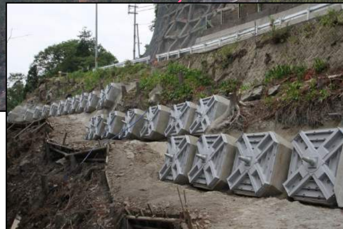
アンカー工 1期工事完成状況
