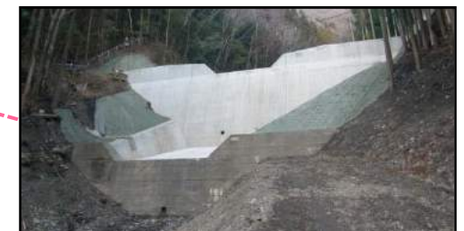
第1号谷止工 完成状況
