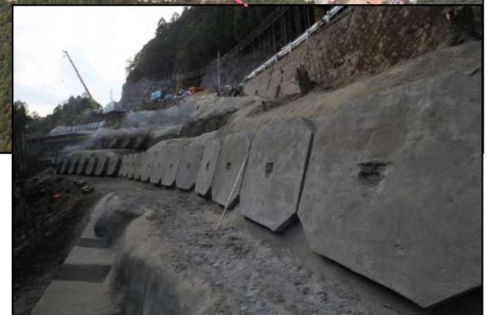
アンカー工 2期工事施工状況
