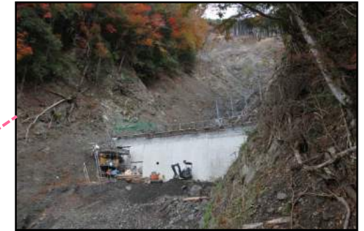
第3号谷止工 施工状況
