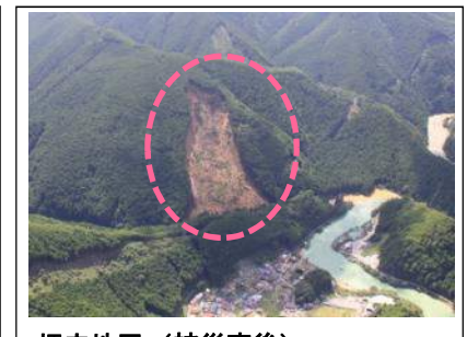
坪内地区 (被災直後) ・崩壊規模 4.3ha ・対策: 床固工
