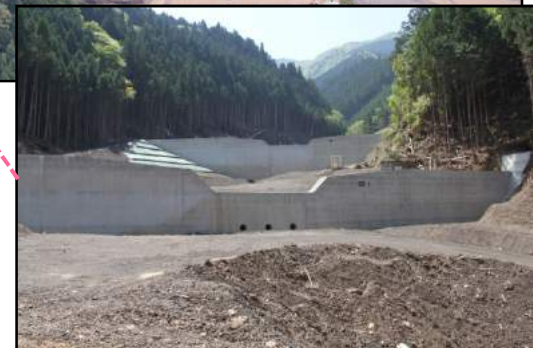
第2号谷止工完成状況
