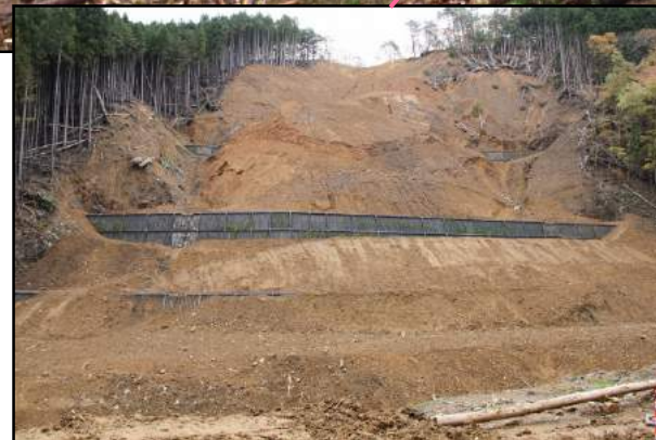
鋼製砕土留工 完成状況
