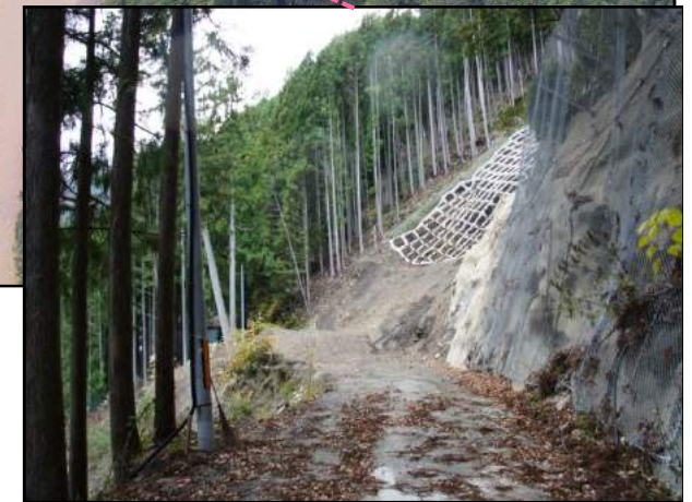
施工箇所下部状況
