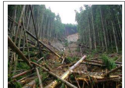
川合(深谷)地区 (被災直後) ・崩壊規模 0.54ha ・対策: 山腹工
