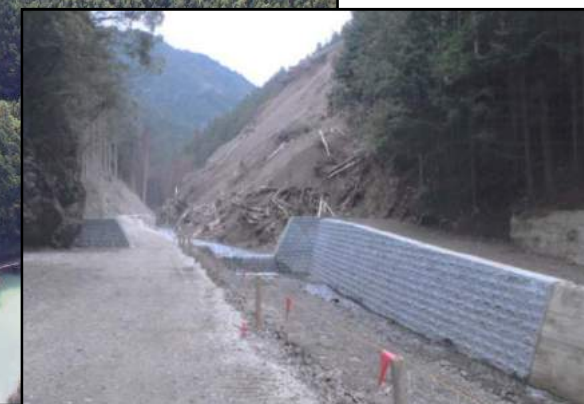
第1号床固工、護岸工 完成状況
