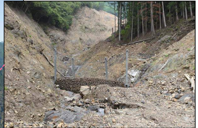
崩壊地上部 落石防止工 施工状況
