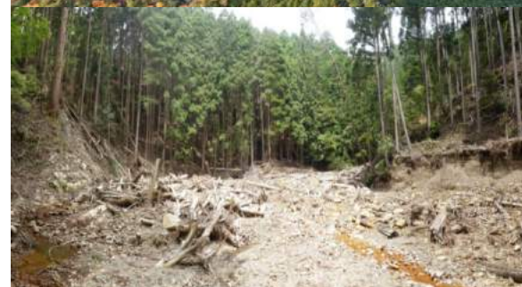
① 谷止工施工前の状況
