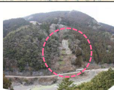
堂平地区 (被災直後) ・地すべり兆候の規模 4.0ha ・対策: アンカー工
