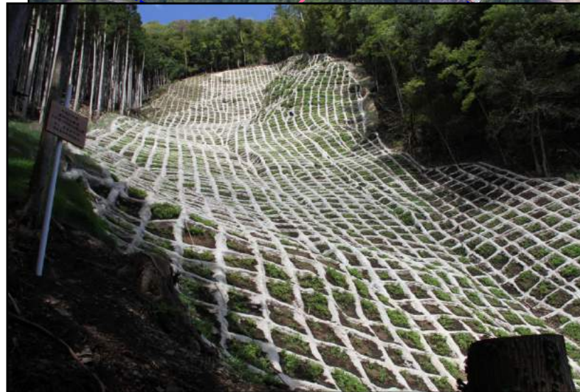
山腹工 完成状況
