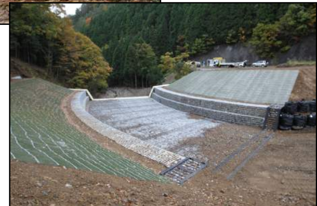
流路工 完成状況
