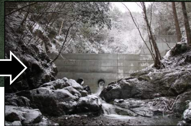
第1号谷止 完成状況
