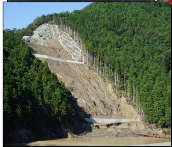
NO.1、NO.2土留工完成状況
