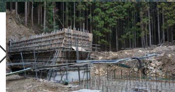
現在の状況(左岸施工中)
