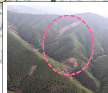
栃尾(桑谷)地区 (被災直後) ・崩壊規模 1.5ha ・対策: 谷止工
