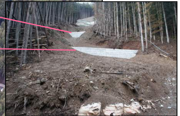
施工状況 (村道下部)
