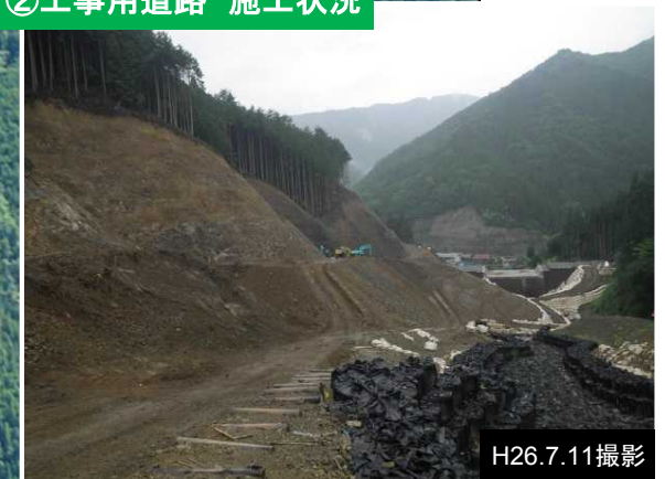
②工事用道路 施工状況
