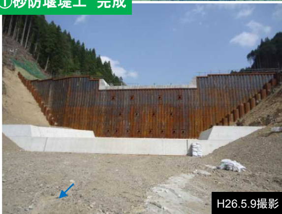
①砂防堰堤工 完成
