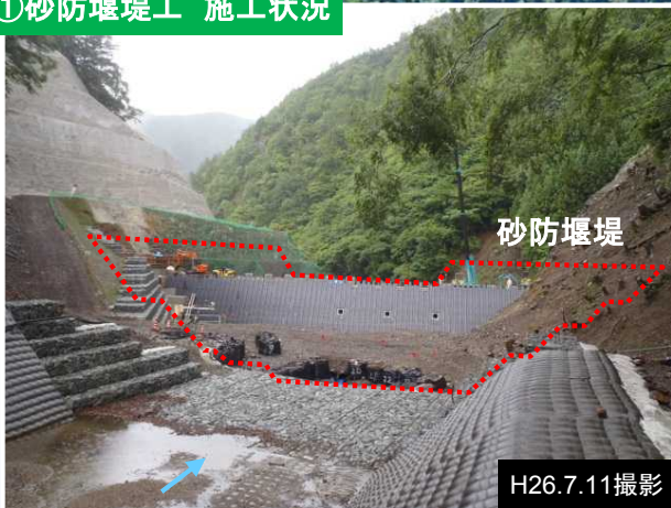
①砂防堰堤工 施工状況
