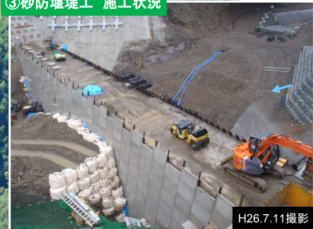
③砂防堰堤工 施工状況
