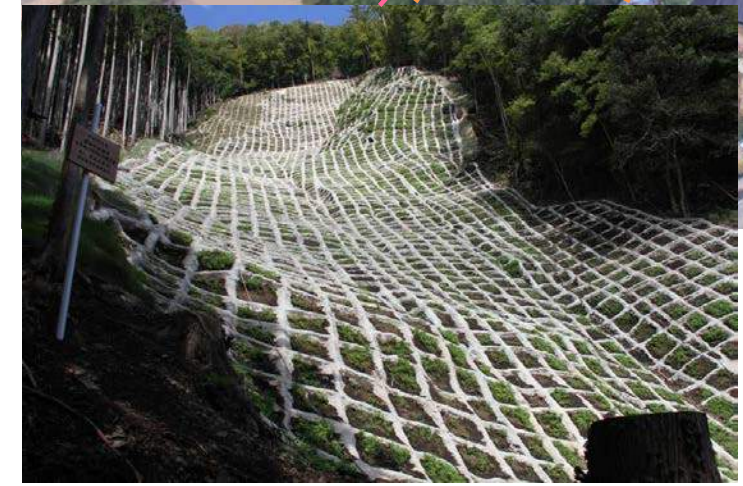
山腹工 完成状況 (H25年度完成)
