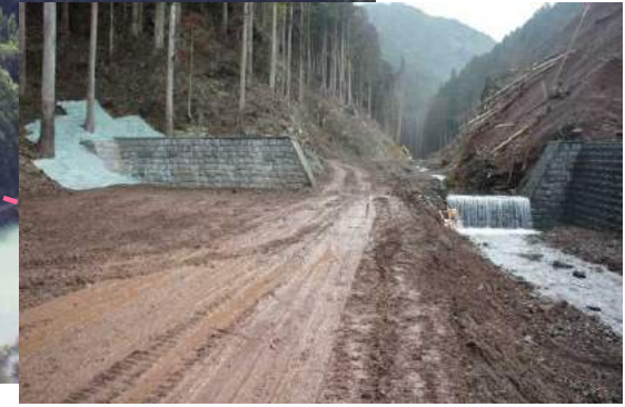
第2号床固工 完成状況
