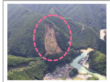
⑯坪内地区(被災直後) ・崩壊規模 4.3ha ・対策: 床固工
