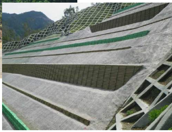
木製校倉式土留工、木製筋工
