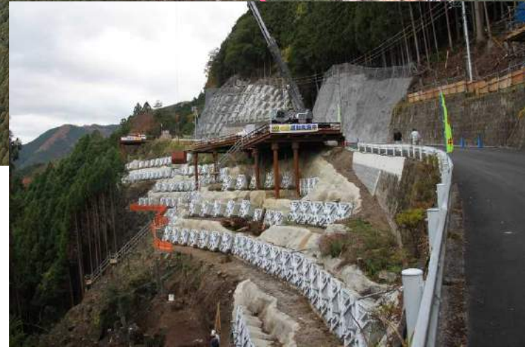
アンカー工 掘削状況
