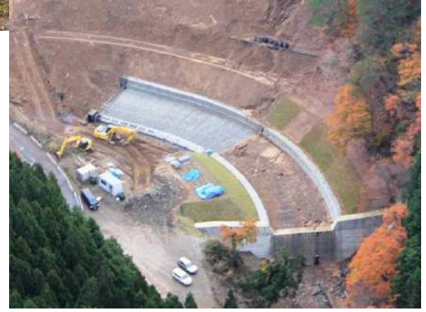
流路工 施工状況
