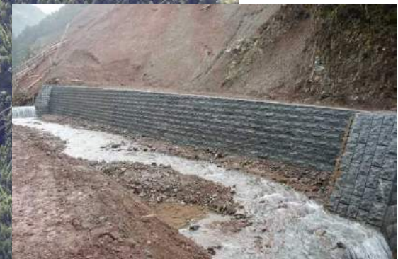
護岸工 完成状況
