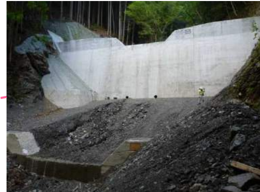
第2号谷止工 完成状況
