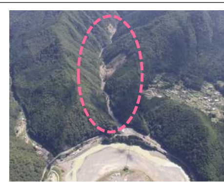
③高津地区(被災直後) ・崩壊規模 3.33ha ・対策: 谷止工、山腹工
