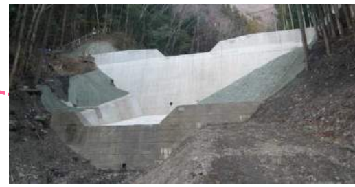
第1号谷止工 完成状況
