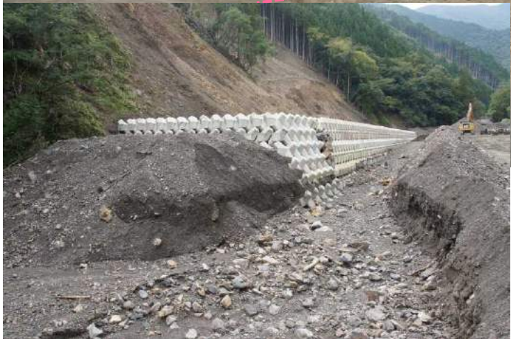
コンクリートブロック護岸工 施工状況
