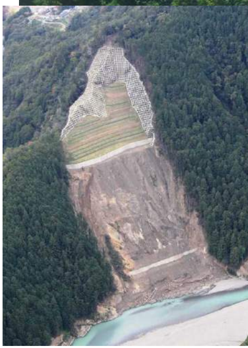
山腹工 進捗状況
