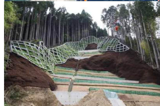
山腹工 完成状況
