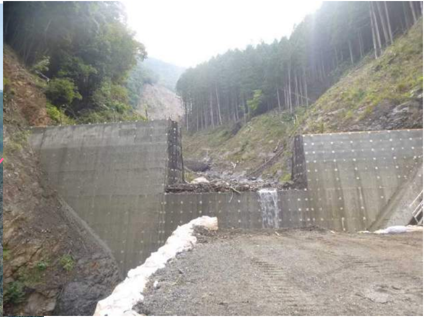
第4号谷止工 施工状況
