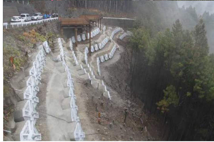
アンカー工 完成状況
