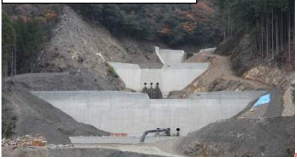
④十津川村野尻の完成状況
