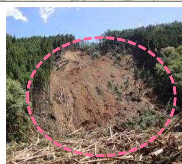
⑭檜股地区(被災直後) ・崩壊規模 2.3ha ・対策: 谷止工及び山腹工
