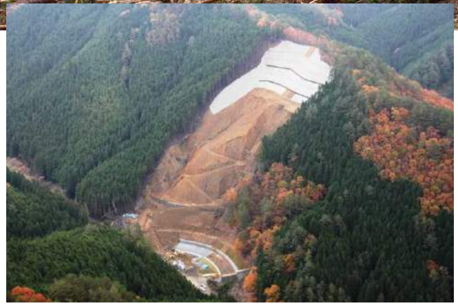
山腹工 進捗状況
