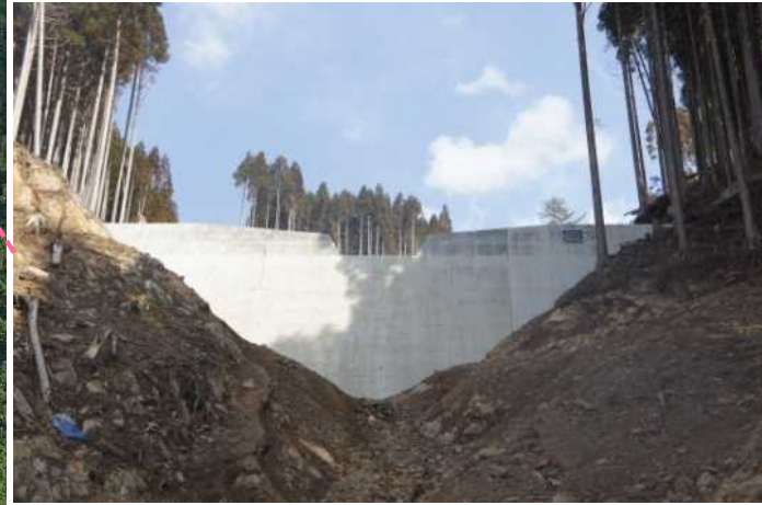
B谷第1号谷止工 完成状況
