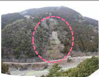
⑫堂平地区(被災直後) ・地すべり兆候の規模 4.0ha ・対策: アンカー工
