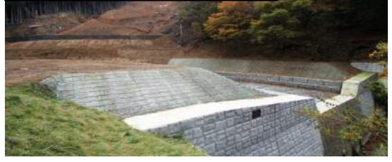
①野迫川村檜股の完成状況
