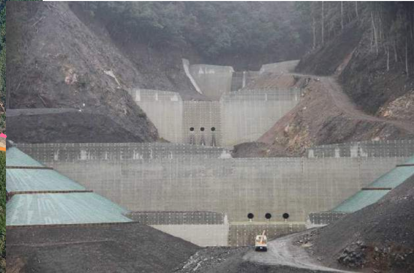
第1～3号谷止工 完成状況
