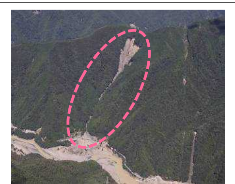
①長殿(テラ谷)地区(被災直後) ・崩壊規模 2.50ha ・対策: 谷止工、山腹工
