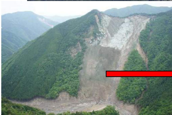
航空実播工 完成状況 (H26)
