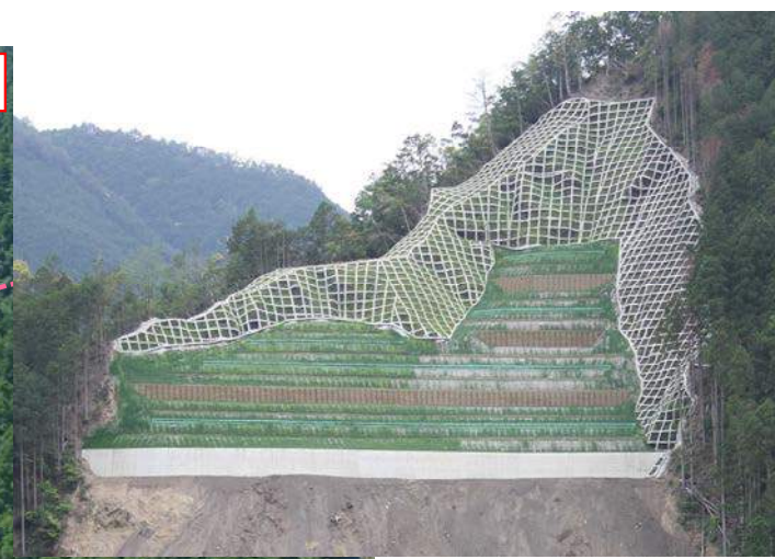
上部法面 完成状況
