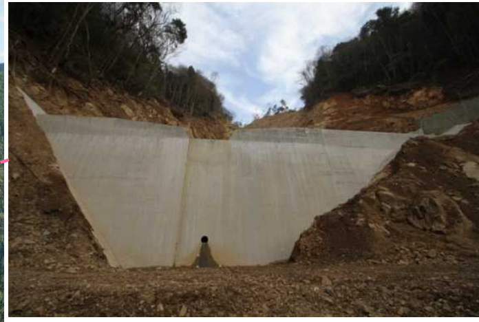
A谷第1号谷止工 完成状況
