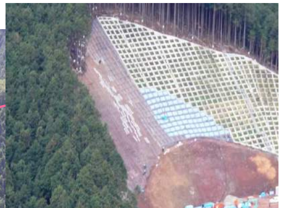
法枠工 施工状況
