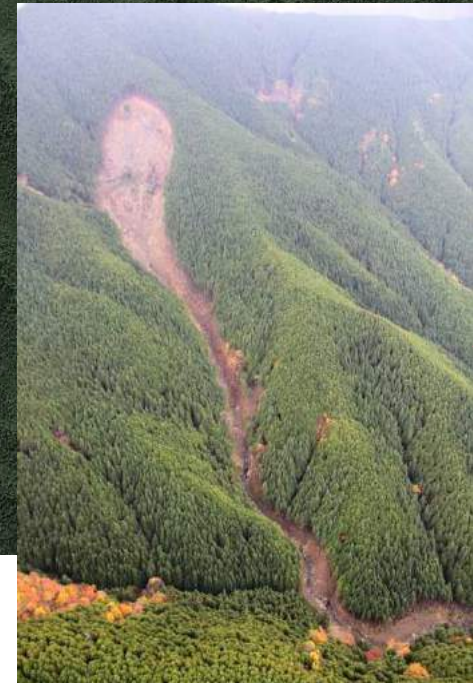
最上部崩壊地の状況
