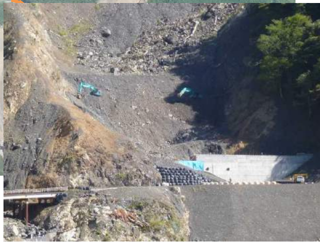
第1号谷止、第2号谷止施工状況
