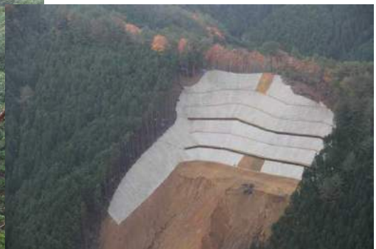
マット伏工 施工状況
