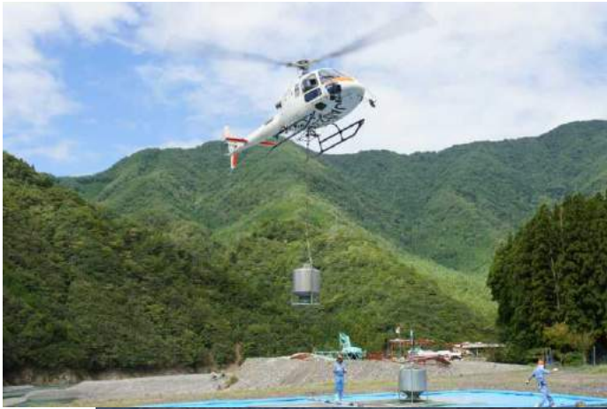
ヘリコプターによる施工状況
