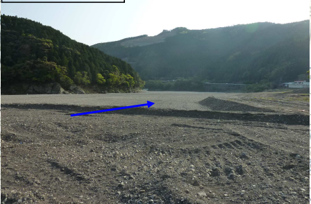
本宮地区 土砂撤去
