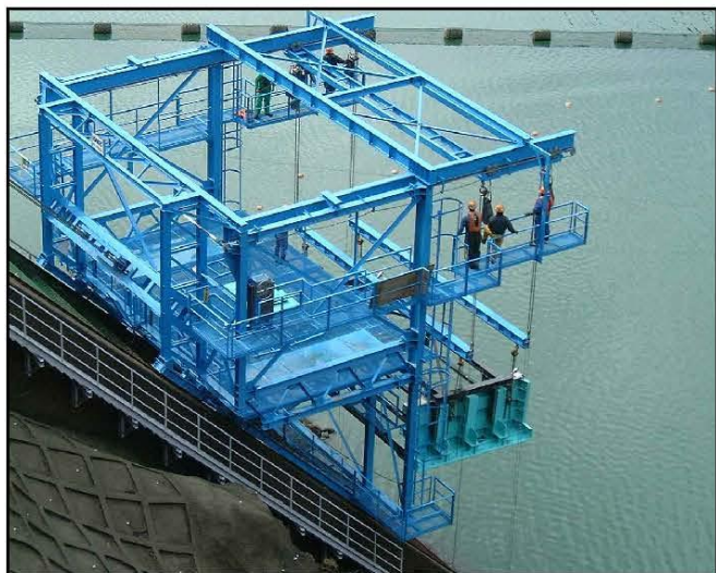
戸当り金物据付状況 （坂本ダム表面取水設備工事の例）
