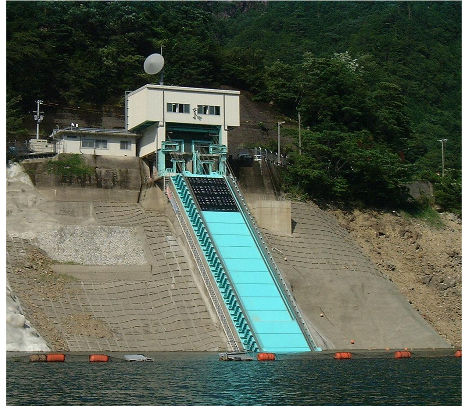
設備改造イメージ (同形式の構造である坂本ダム表面取水設備)
