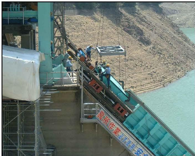
扉体据付状況 （坂本ダム表面取水設備工事の例） ※ 風屋ダムでは設備規模がこれよりも大きくなります。
