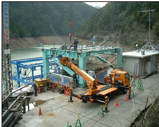
開閉装置架台据付状況 （坂本ダム表面取水設備工事の例） ※ 風屋ダムでは設備規模がこれよりも大きくなります。
