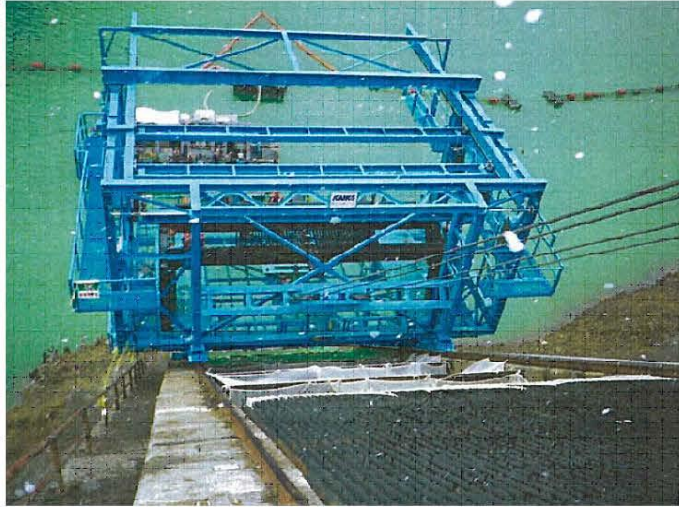
底部発電取水用スクリーン設置状況 （坂本ダム表面取水設備工事の例）
