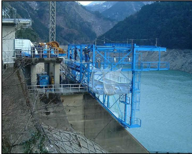
現地据付用仮設台車設置状況 （坂本ダム表面取水設備工事の例） ※ 風屋ダムでは設備規模がこれよりも大きくなります。
