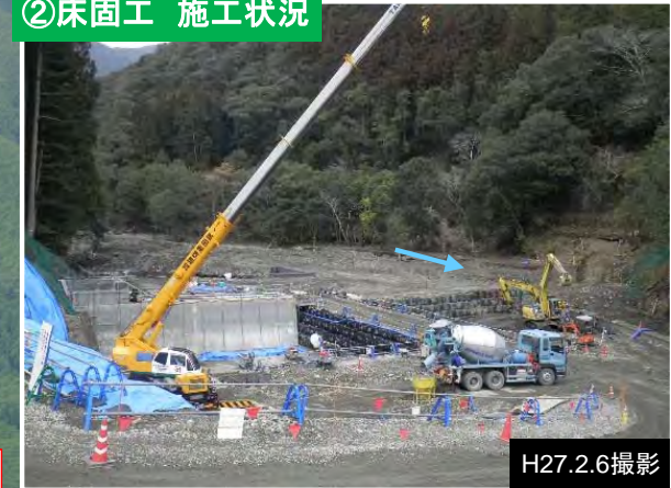
②床固工 施工状況
