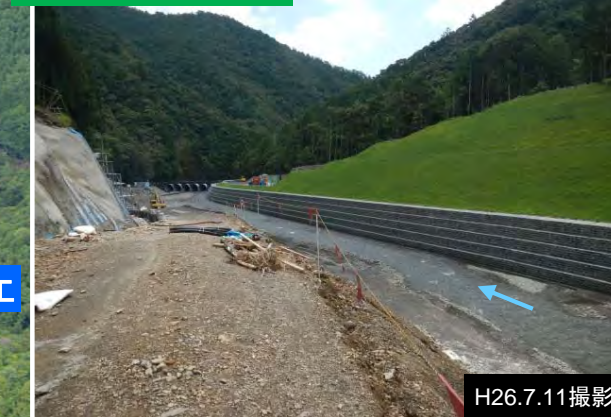
③流路護岸工 完成
