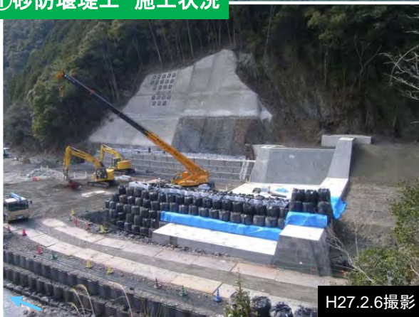
①砂防堰堤工 施工状況
