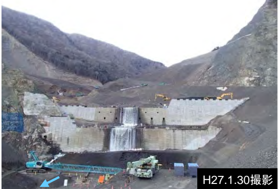
②砂防堰堤工 復旧状況
