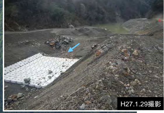
③仮排水路呑口部 復旧状況
