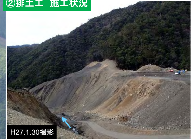
②排土工 施工状況
