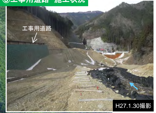
③工事用道路 施工状況
