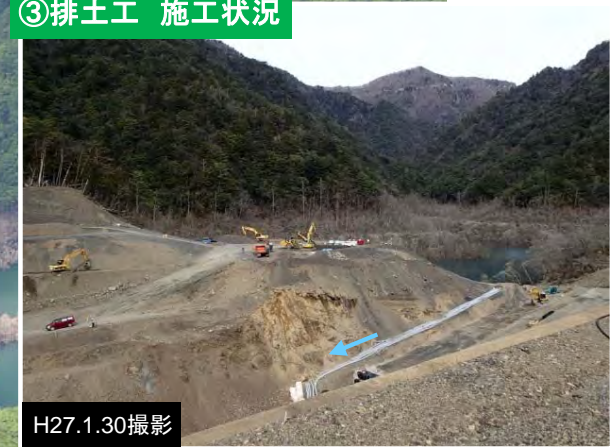
③排土工 施工状況
