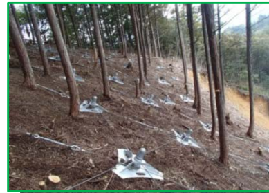
H25地山補強土工 完成状況
