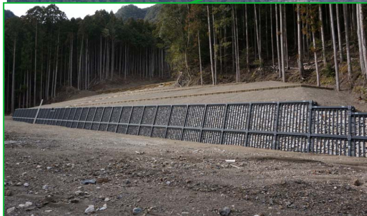
鋼製枠護岸工 完成状況
