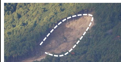
しょうぶだに ③菖蒲谷区域(田辺市本宮町三越) ・崩壊規模 0.90ha ・対策工: 溪間工 山腹工
