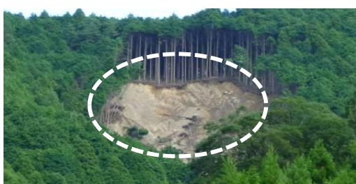
あいがごう ①愛賀合区域(田辺市鮎川) ・崩壊規模 0.72ha ・対策工: 溪間工 山腹工
