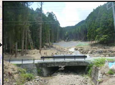
完成状況⑪(新宮市相賀)
