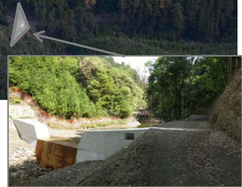
H24和歌山県施工
