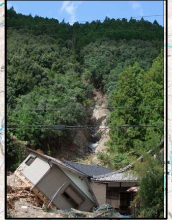
被災状況⑩(新宮市熊野川町九重和田)
