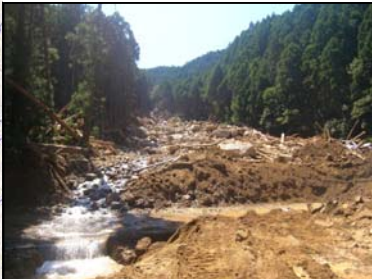
被災状況⑪(新宮市相賀)
