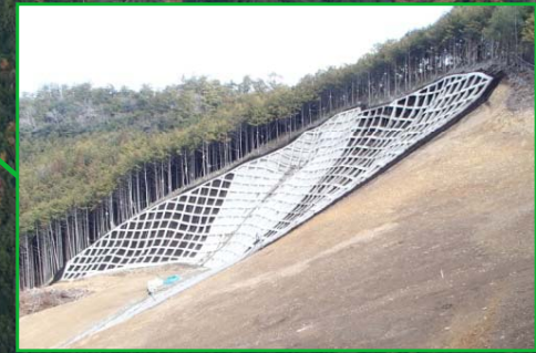
法枠工 完成状況
