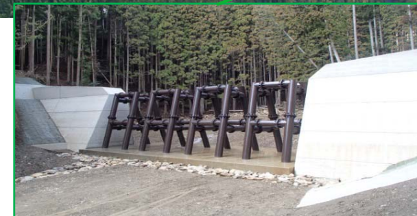
H25第2号谷止工 完成状況
