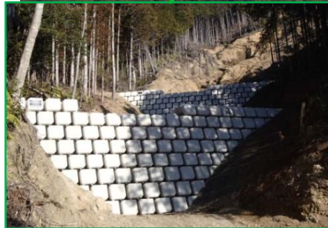
H25第2号谷止工 完成状況
