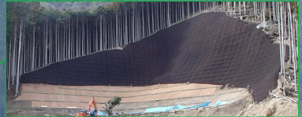
植生法枠工 完成状況
