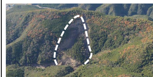
しもたににしがわ ④下モ谷西側区域(田辺市本宮町上切原) ・崩壊規模 5.40ha ・対策工: 溪間工 山腹工
