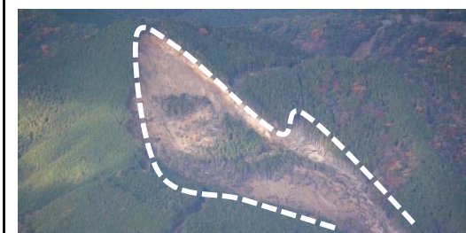
かみへいじがわ ⑤上平治川区域(田辺市本宮町皆地) ・崩壊規模 6.26ha ・対策工: 溪間工 山腹工
