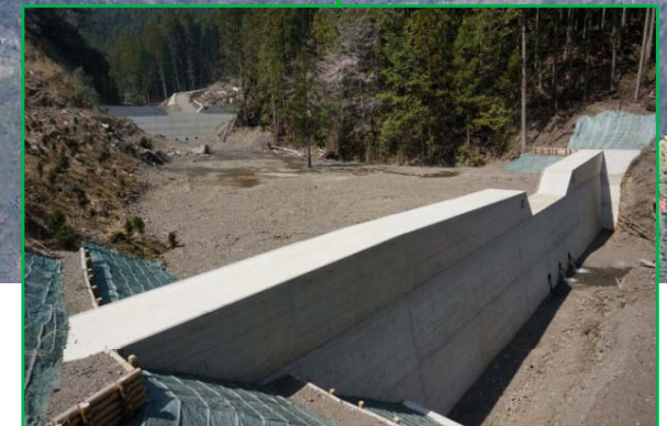
第1号谷止工 完成状況
