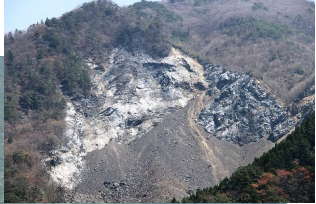
山腹工 完成状況
