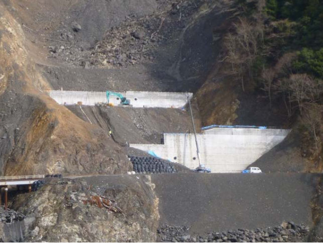
第1号谷止、第2号谷止施工状況
