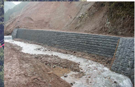
護岸工 完成状況
