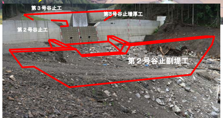
第2号谷止工 現地状況
