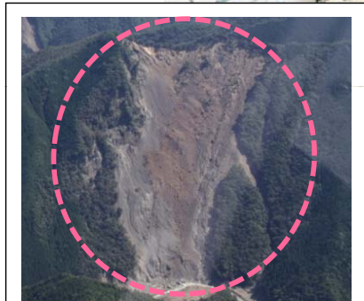
⑫赤谷地区 (被災直後) ・崩壊規模 24.9ha ・対策：山腹工
