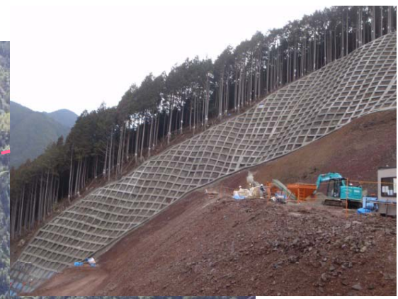
法枠工 施工状況
