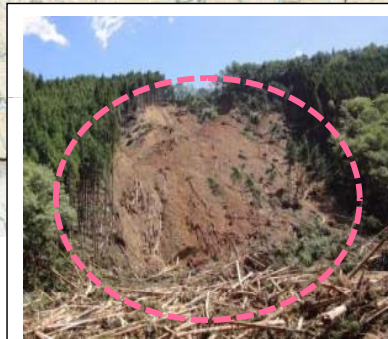
⑬檜股地区 (被災直後) ・崩壊規模 2.3ha ・対策：谷止工及び山腹工
