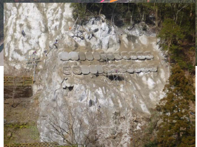
アンカー工 施工状況
