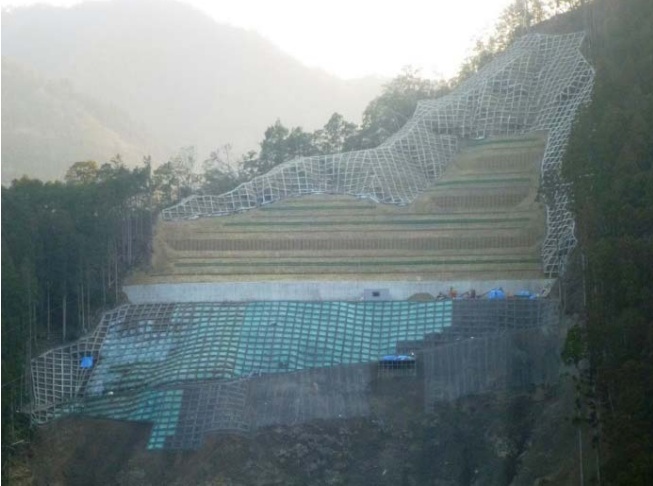
法枠工 施工状況(2期工事)
