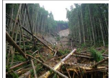
⑮川合(深谷)地区 (被災直後) H25事業完了 ・崩壊規模 0.54ha ・対策：山腹工
