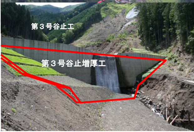
第3号谷止工 現地状況
