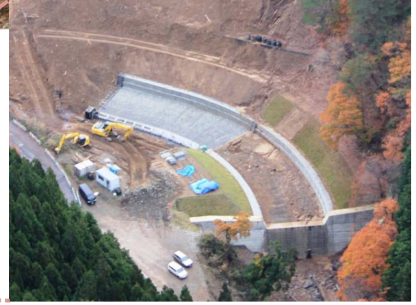
流路工 施工状況
