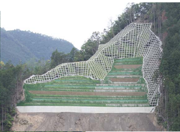
上部法面 完成状況 (1期工事)
