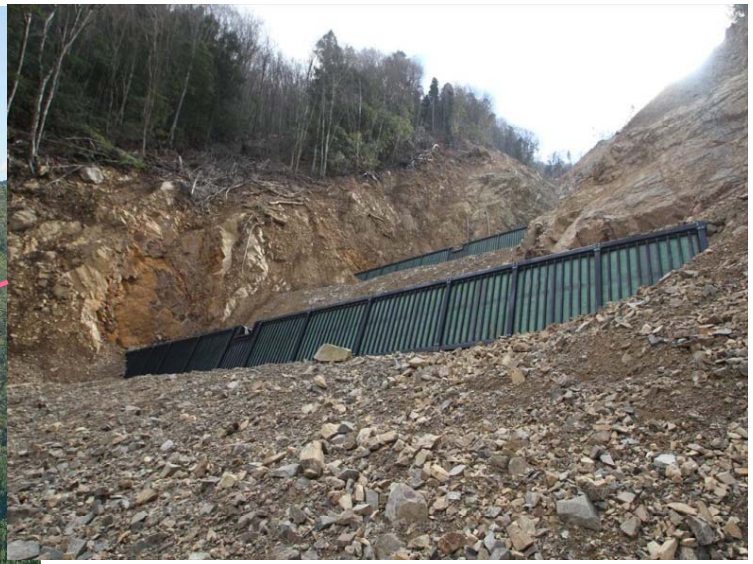
鋼製砕土留工 完成状況
