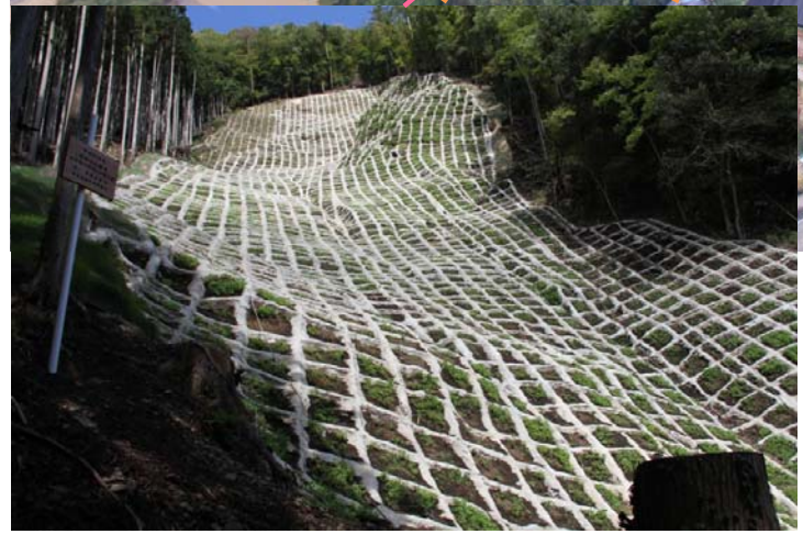
山腹工 完成状況 (H25年度完成)
