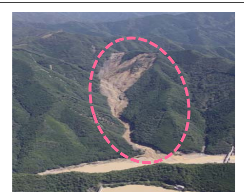
⑧野尻地区(被災直後) ・崩壊規模 20.44ha ・対策: 谷止工、山腹工
