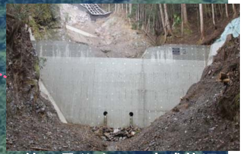
第2号谷止工 完成状況
