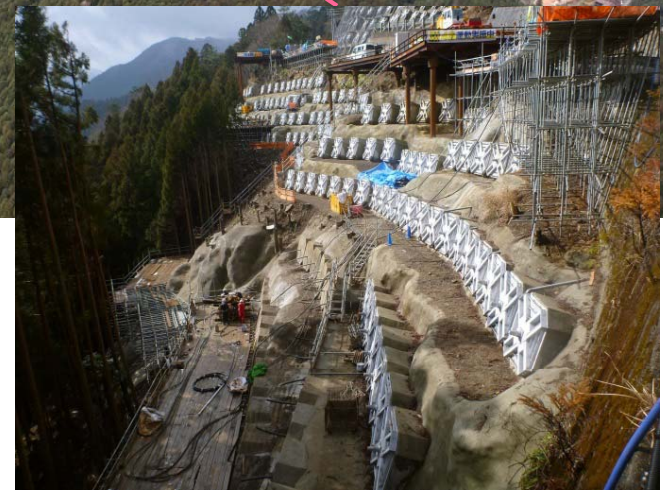
アンカー工 施工状況
