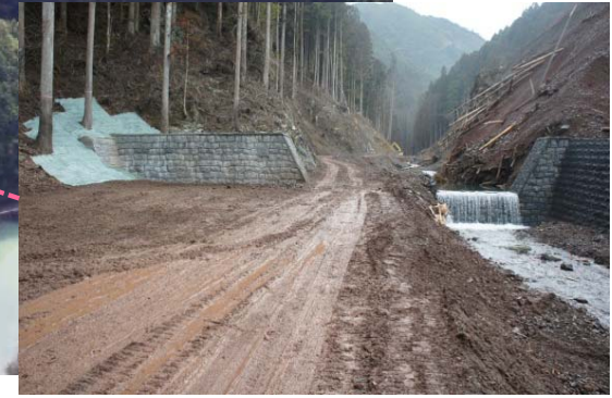
第2号床固工 完成状況
