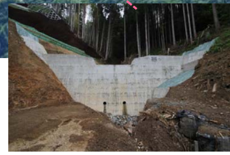
第1号谷止工 完成状況
