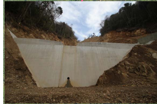
A谷第1号谷止工 完成状況
