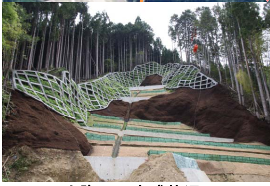
山腹工 完成状況
