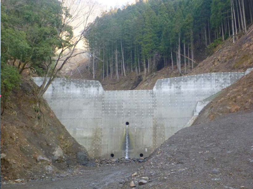
第4号谷止工 完成状況
