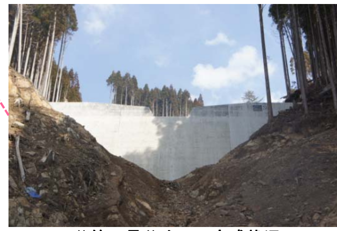
B谷第1号谷止工 完成状況
