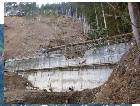
第6号谷止工施工状況
