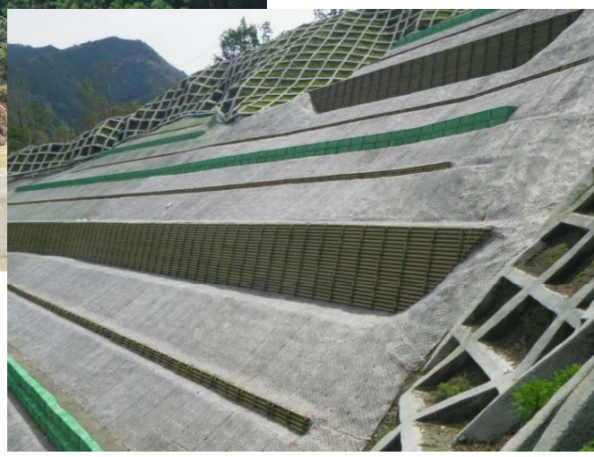
木製枝倉式土留工、木製筋工
