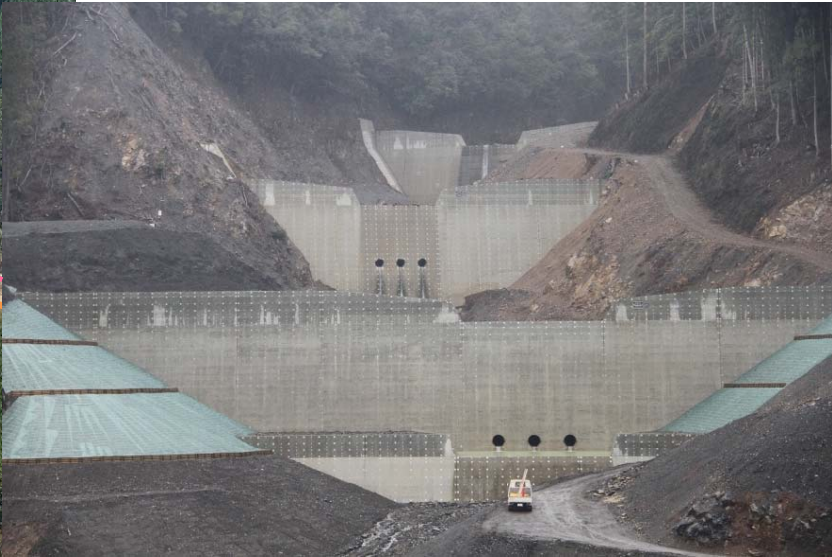
第1～3号谷止工 完成状況
