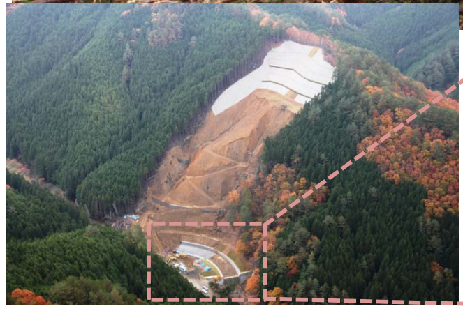
山腹工 進捗状況
