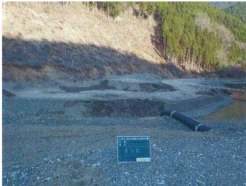
着工前 (撮影H26.4.1)
