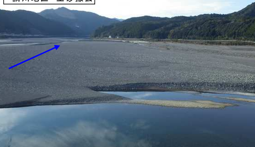
請川地区 土砂撤去
