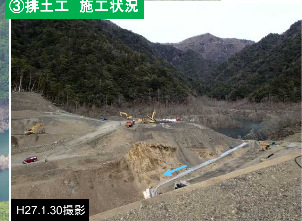
③排土工 施工状況
