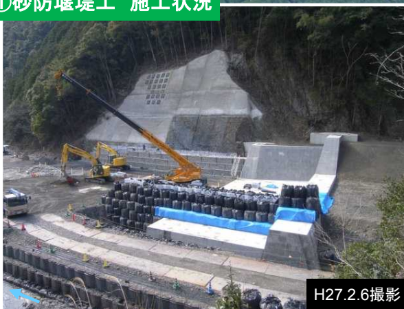
①砂防堰堤工 施工状況
