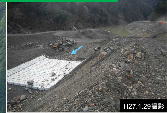
③仮排水路呑口部 復旧状況
