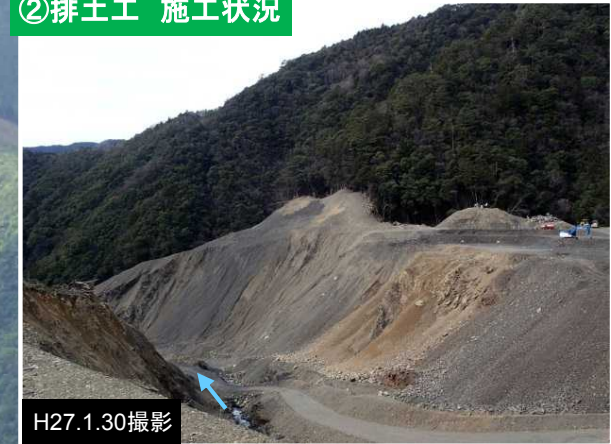
②排土工 施工状況
