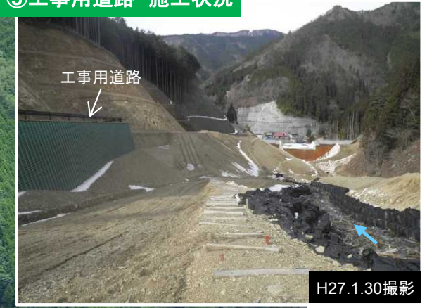
③工事用道路 施工状況
