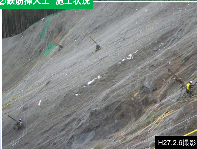
②鉄筋挿入工 施工状況
