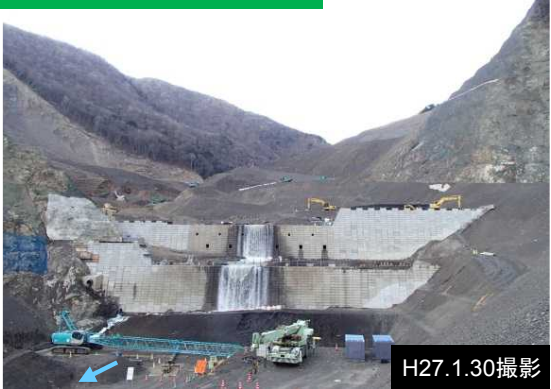
②砂防堰堤工 復旧状況
