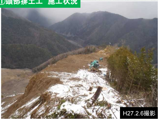
①頭部排土工 施工状況
