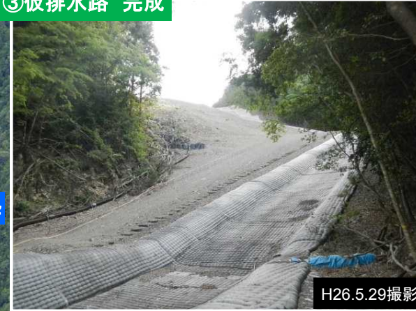
③仮排水路 完成
