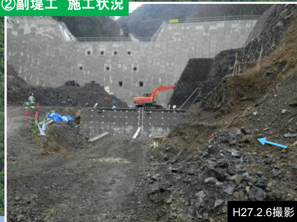
②副堤工 施工状況
