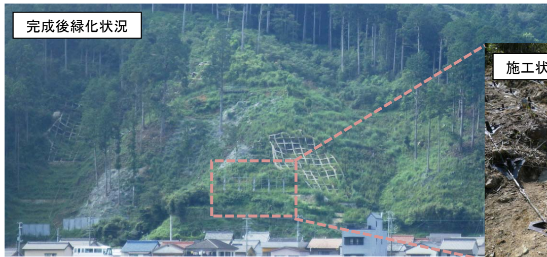
地山補強土工(ノンフレーム工法)
