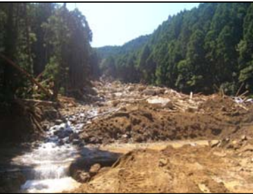
被災状況⑪(新宮市相賀)
