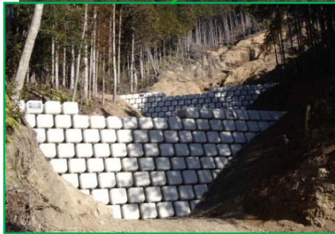
H25第2号谷止工 完成状況
