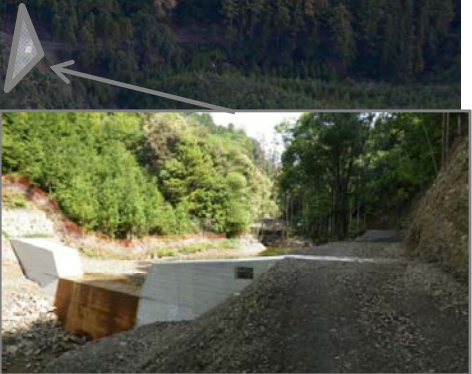
H24和歌山県施工
