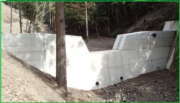
第1号谷止工 完成状況
