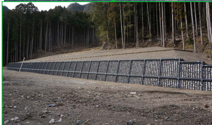
鋼製枠護岸工 完成状況
