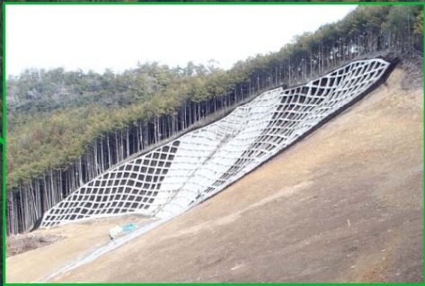
法枠工 完成状況
