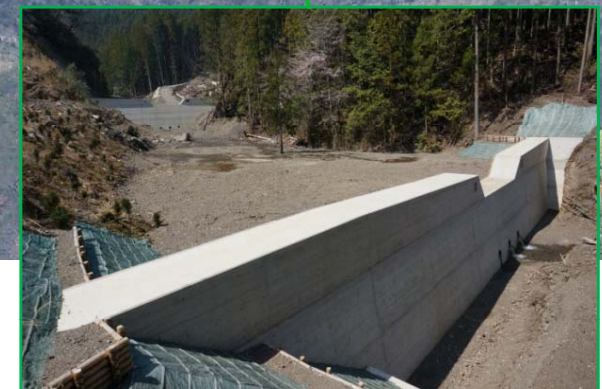
第1号谷止工 完成状況
