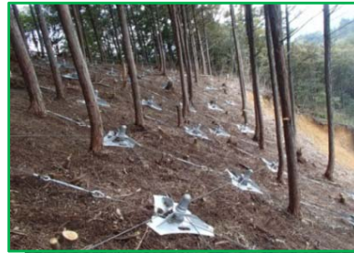
H25地山補強土工 完成状況
