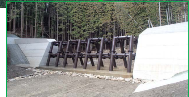
H25第2号谷止工 完成状況
