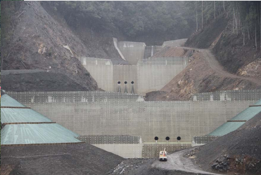
第1～3号谷止工 完成状況
