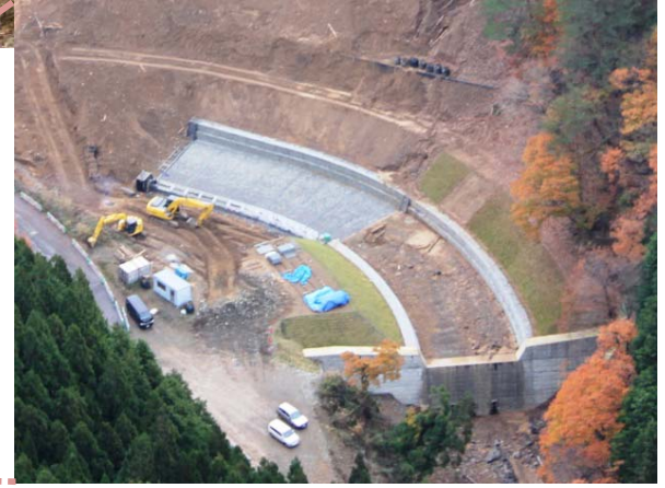
流路工 施工状況
