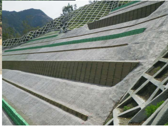
木製枝倉式土留工、木製筋工
