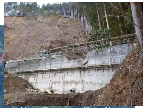
第6号谷止工施工状況
