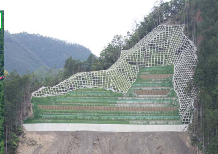
上部法面 完成状況 (1期工事)
