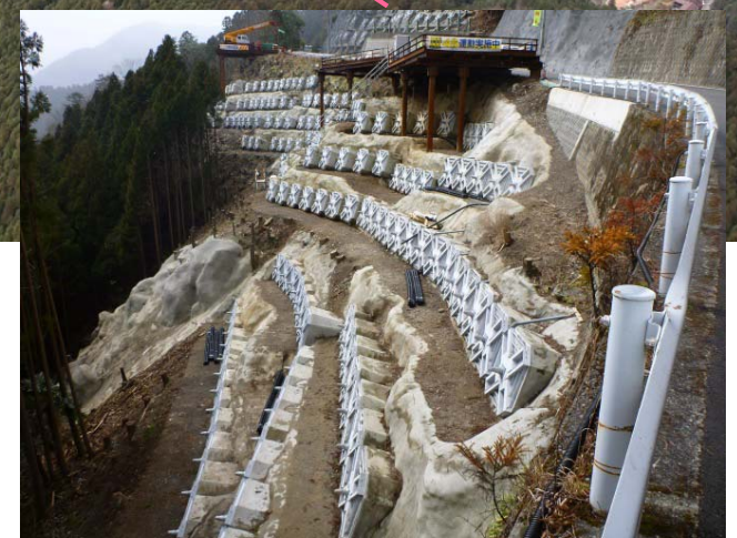
アンカー工 施工状況
