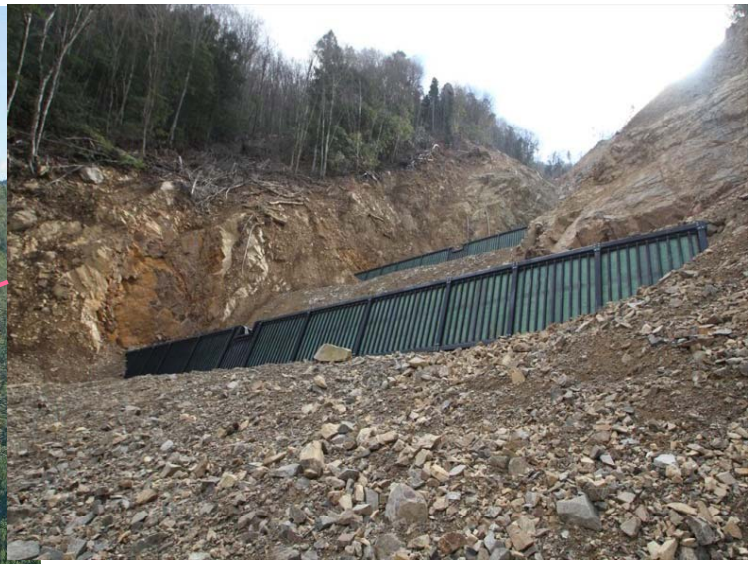
鋼製砕土留工 完成状況
