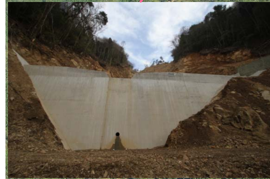
A谷第1号谷止工 完成状況
