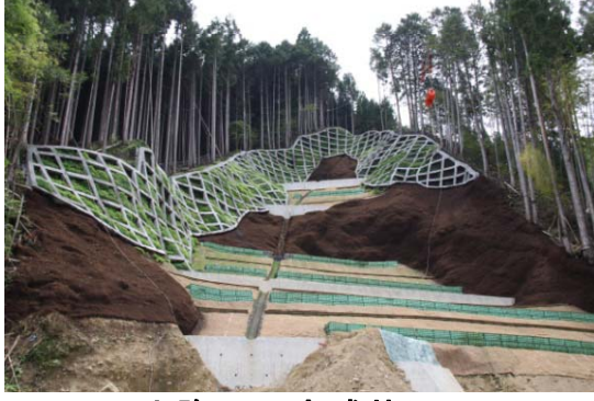
山腹工 完成状況
