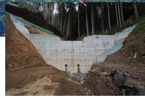
第1号谷止工 完成状況
