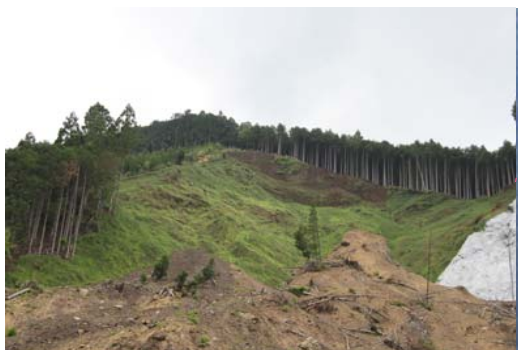
山腹工 完成状況
