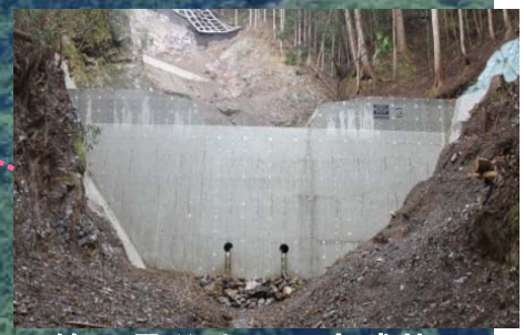
第2号谷止工 完成状況
