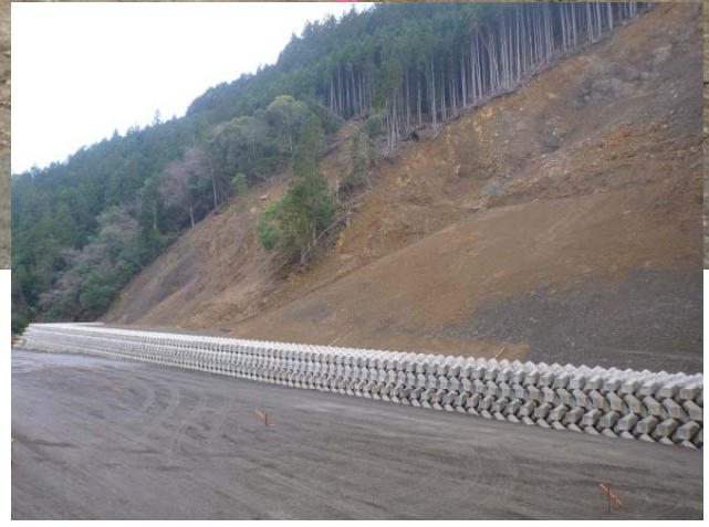
コンクリートブロック護岸工 施工状況
