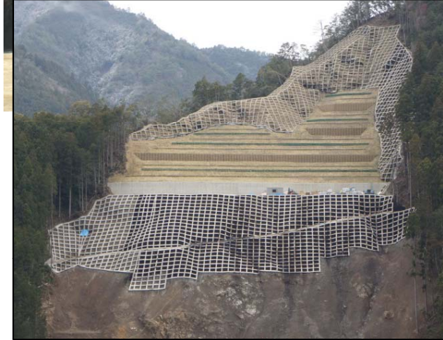
法枠工 施工状況(2期工事)
