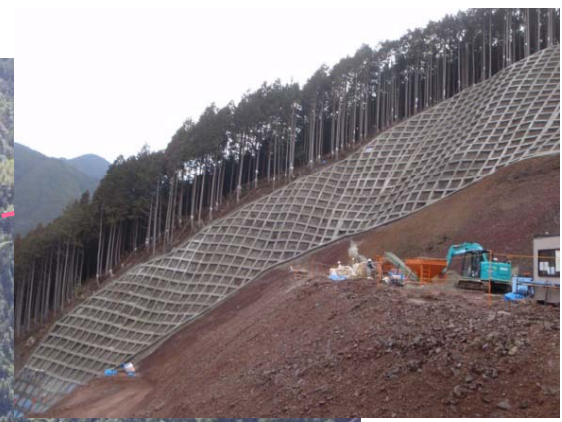
法枠工 施工状況
