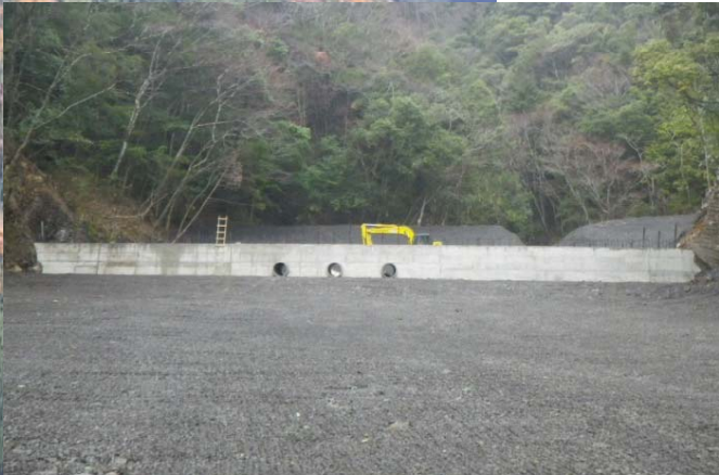
1号谷止 施工状況
