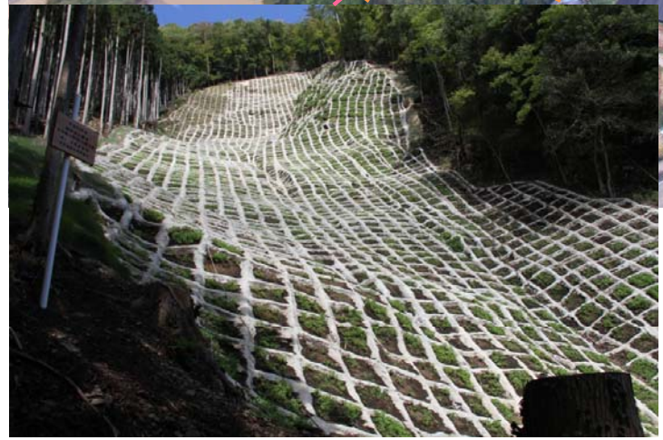
山腹工 完成状況 (H25年度完成)
