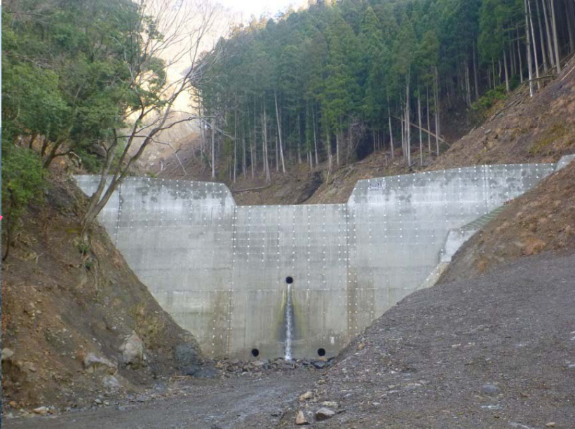
第4号谷止工 完成状況
