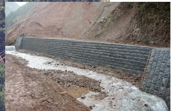
護岸工 完成状況
