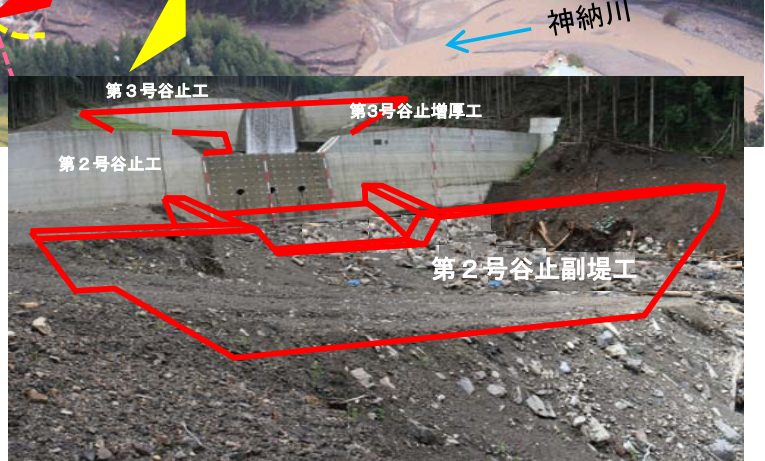
第2号谷止工 現地状況
