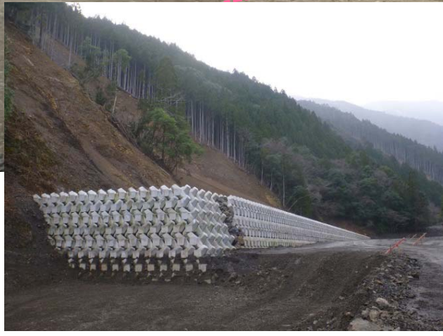
コンクリートブロック護岸工 施工状況
