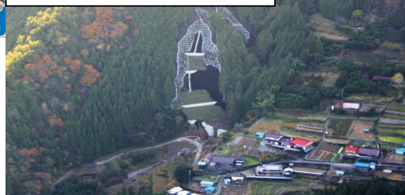
②十津川村山天の完成状況
