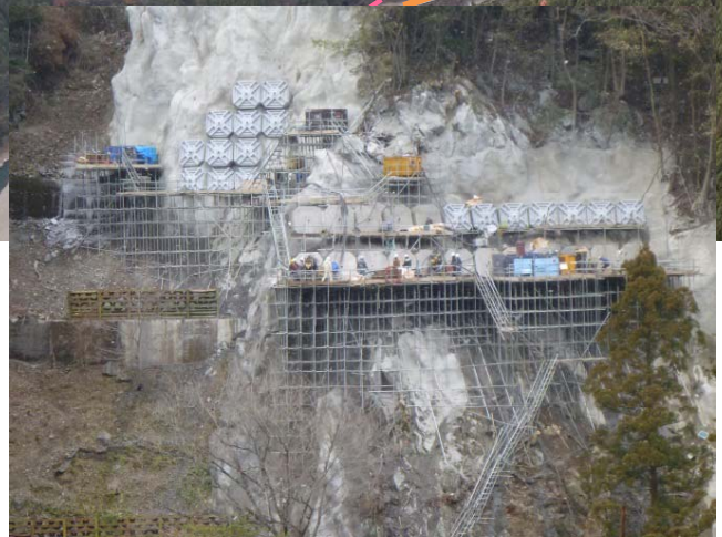
アンカー工 施工状況
