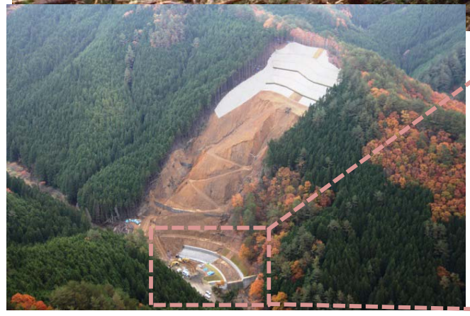
山腹工 進捗状況
