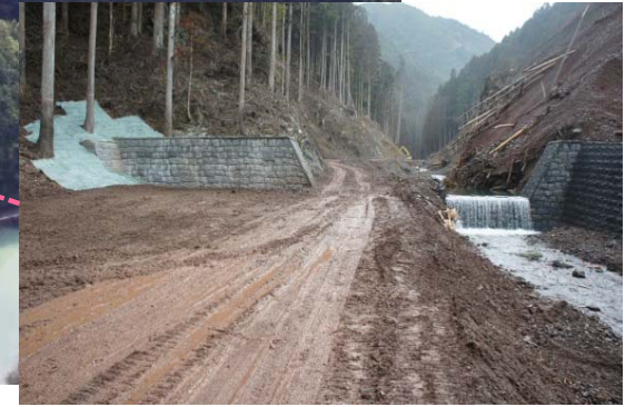
第2号床固工 完成状況
