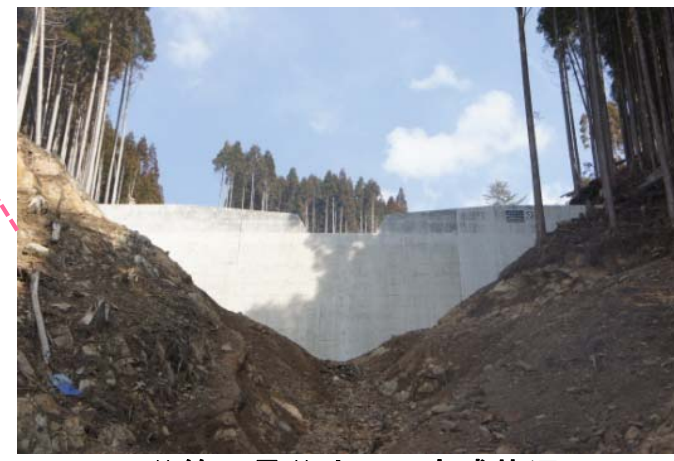
B谷第1号谷止工 完成状況
