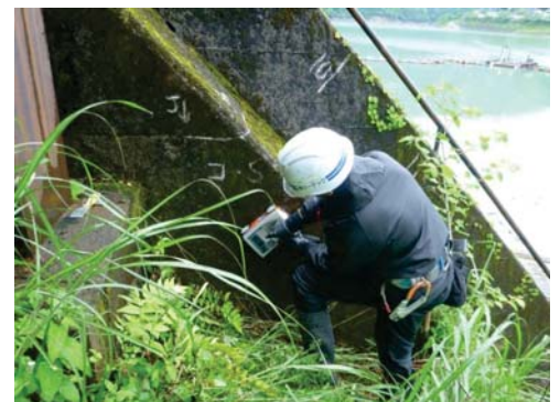
取水口コンクリート強度調査実施状況(鉄筋調査)
