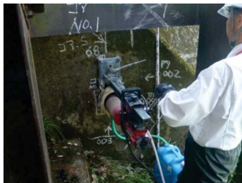
取水口コンクリート強度調査実施状況(コンクリートコア採取)
