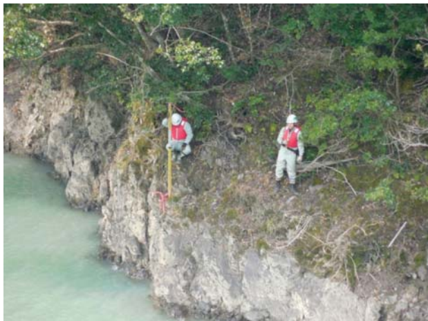
フェンスを固定するアンカー設置箇所での測量
