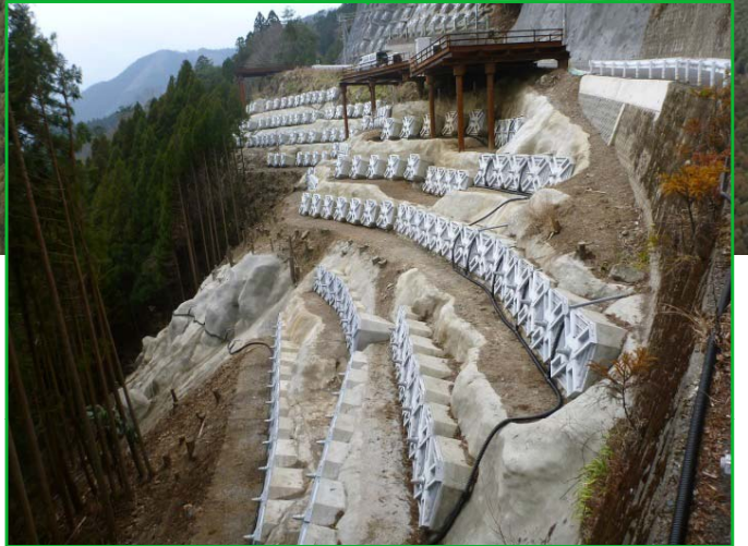
アンカー工 施工状況
