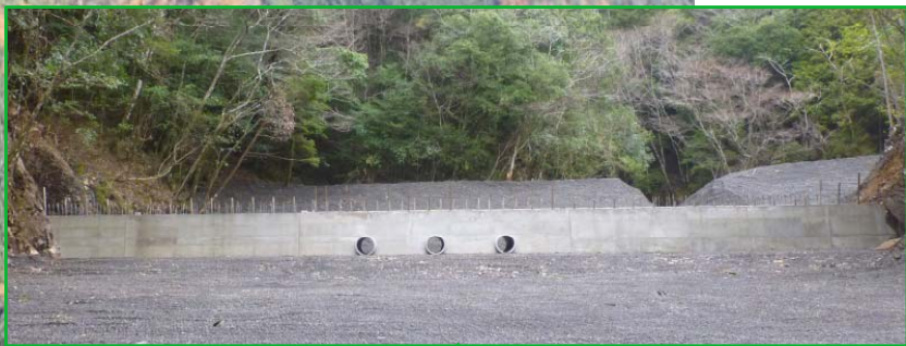
1号谷止 施工状況
