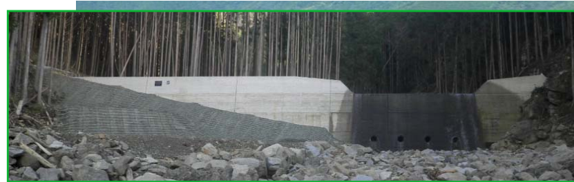
第3号コンクリート谷止工 完成状況
