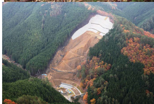
山腹工 進捗状況
