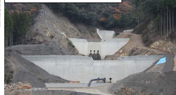
④十津川村野尻の完成状況
