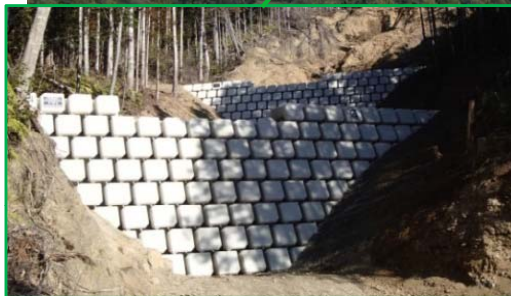
H25第2号谷止工 完成状況
