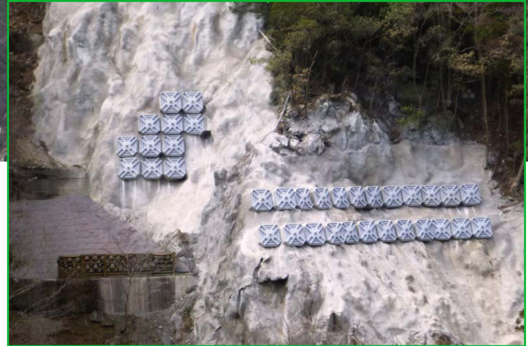
アンカー工 施工状況
