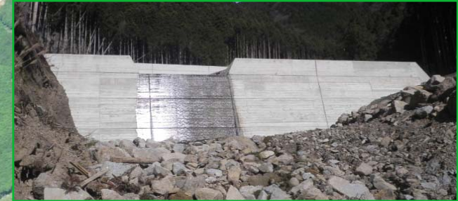
コンクリート土留工 完成状況
