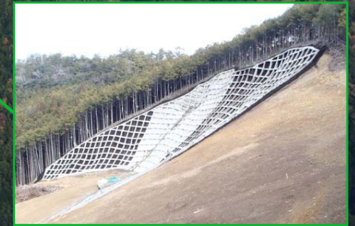
法枠工 完成状況
