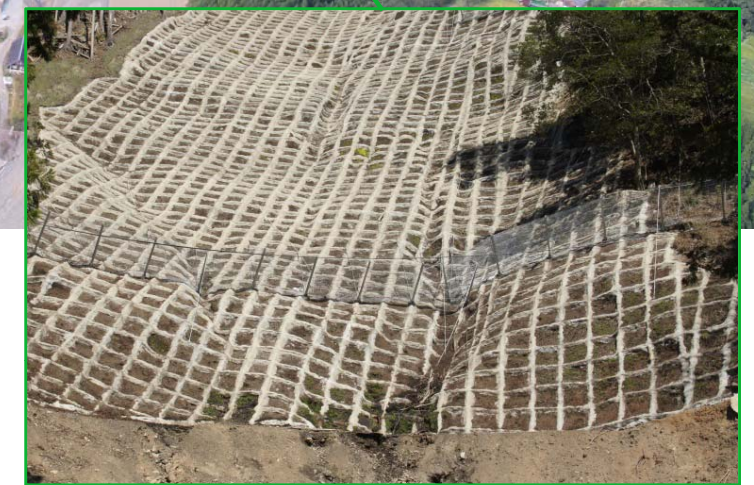
安全対策工 完成状況 (H26年度完成)
