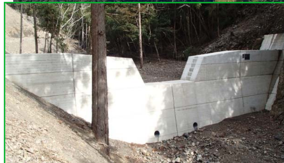
第1号谷止工 完成状況
