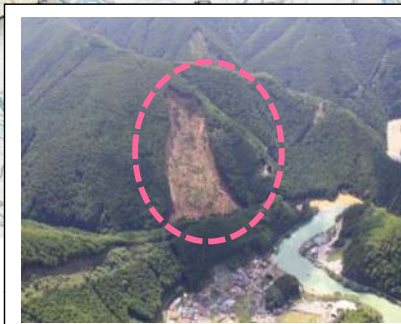
⑭坪内地区(被災直後) ・崩壊規模 4.3ha ・対策: 床固工
