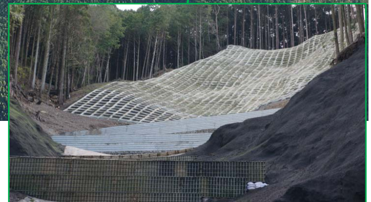
山腹工 完成状況
