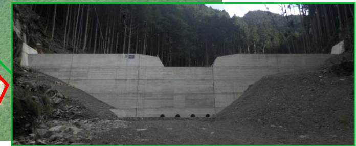
支流第1号コンクリート谷止工 完成状況
