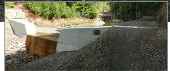
H24和歌山県施工
