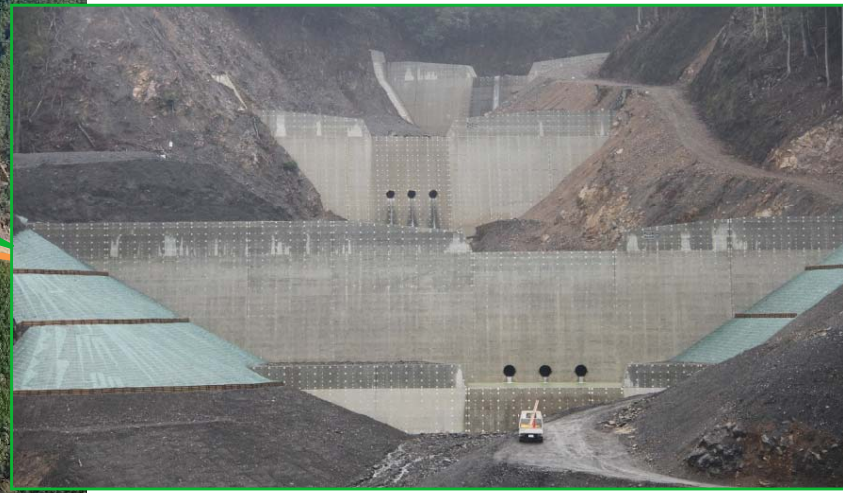
第1～3号谷止工 完成状況
