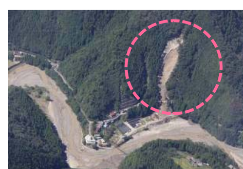
⑤五百瀬地区(1号地)(被災直後) ・崩壊規模 0.47ha ・対策: 山腹工
