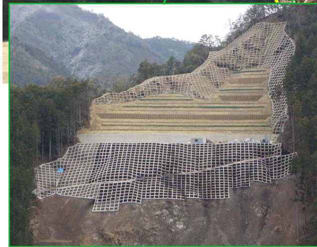
法枠工 施工状況
