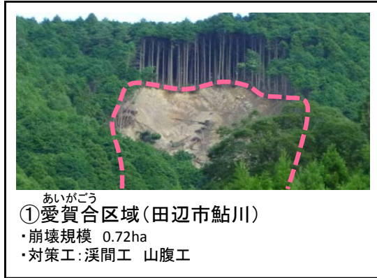
あいがごう ①愛賀合区域(田辺市鮎川) ・崩壊規模 0.72ha ・対策工: 溪間工 山腹工
