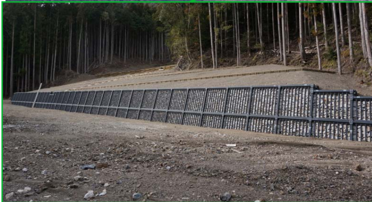
鋼製枠護岸工 完成状況
