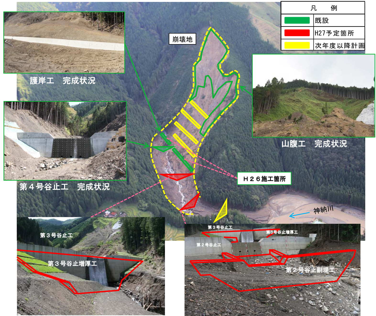
第3号谷止工 現地状況
