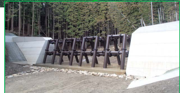
H25第2号谷止工 完成状況
