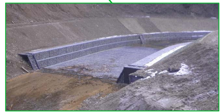
流路工 施工状況
