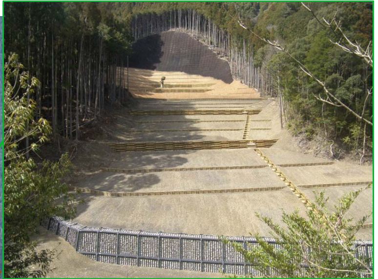
山腹工 完成状況
