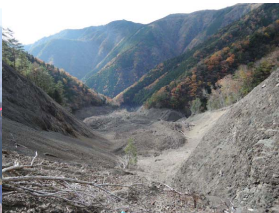
山腹崩壊地より流出した不安定土砂の状況
