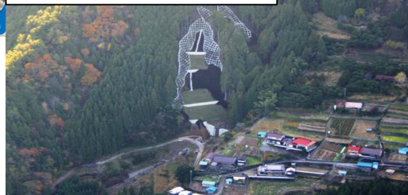
②十津川村山天の完成状況
