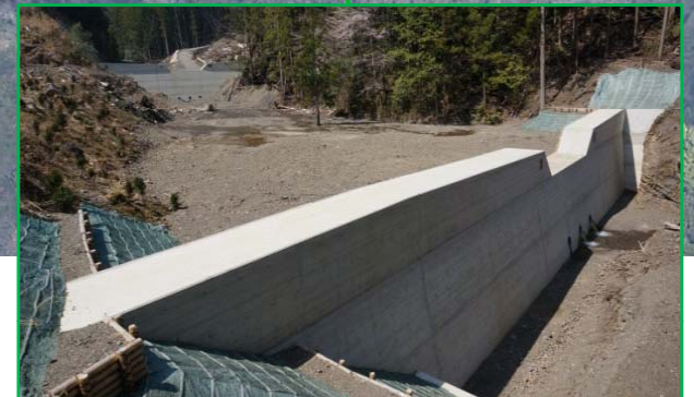
第1号谷止工 完成状況
