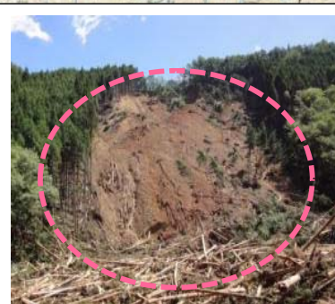
⑬檜股地区(被災直後) ・崩壊規模 2.3ha ・対策: 谷止工及び山腹工
