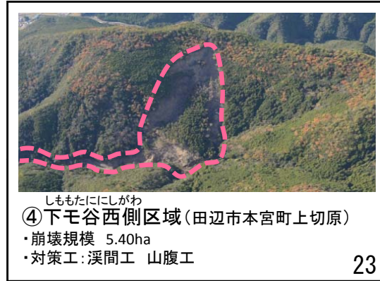
しもたににしがわ ④下毛谷西側区域(田辺市本宮町上切原) ・崩壊規模 5.40ha ・対策工: 溪間工 山腹工
