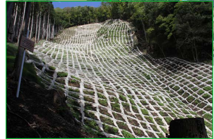
山腹工 完成状況 (H25年度完成)
