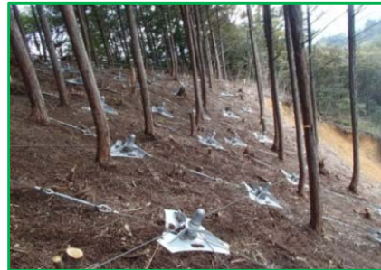
H25地山補強土工 完成状況
