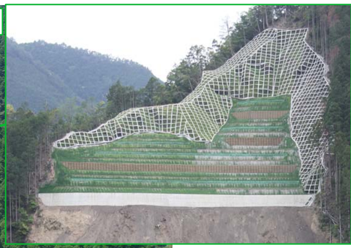
上部法面 完成状況
