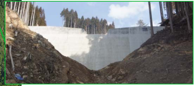
B谷第1号谷止工 完成状況
