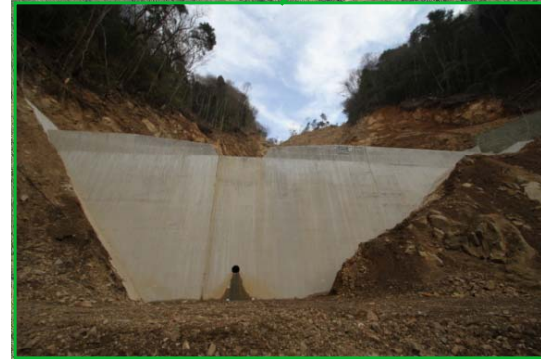
A谷第1号谷止工 完成状況
