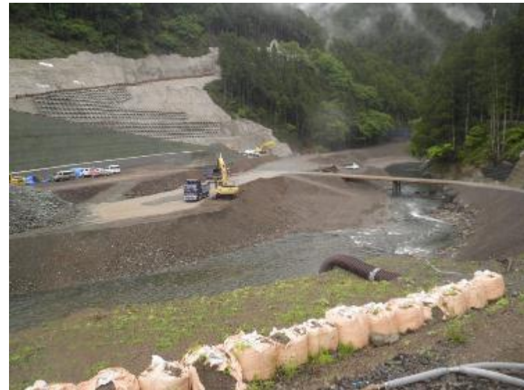
作業状況 (撮影H27.5.30)
