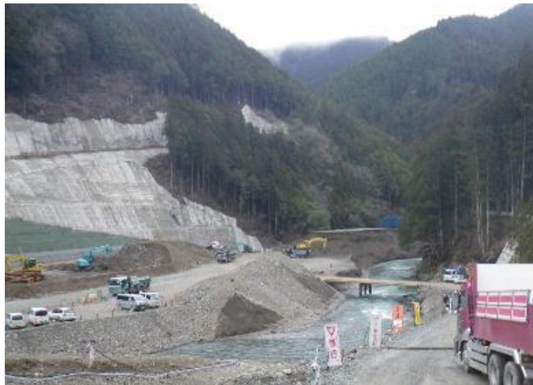
作業状況 (撮影H27.3.20)
