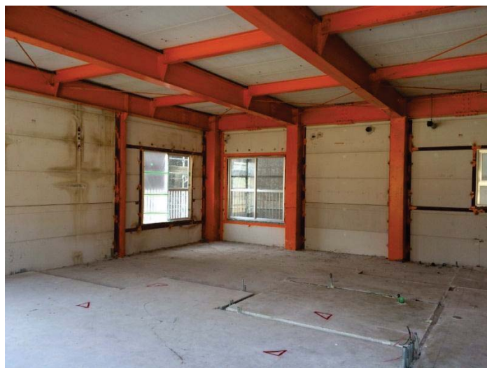
内装撤去状況
