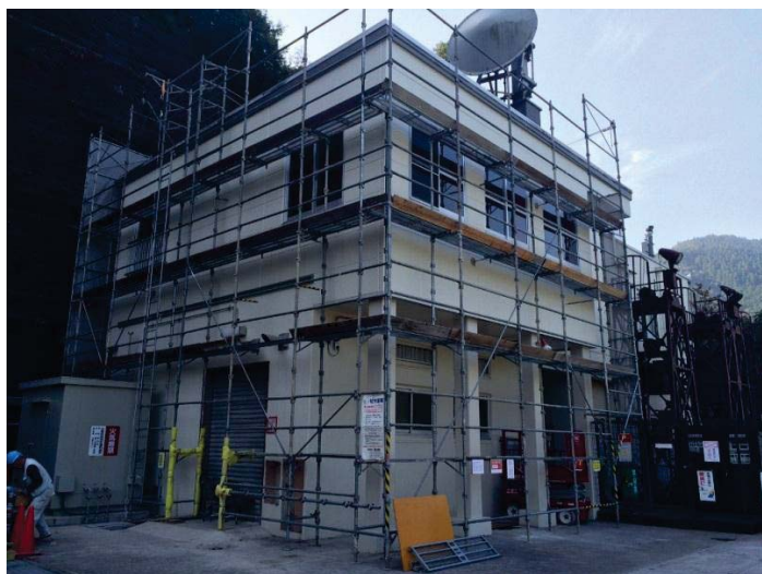
仮設足場設置状況
