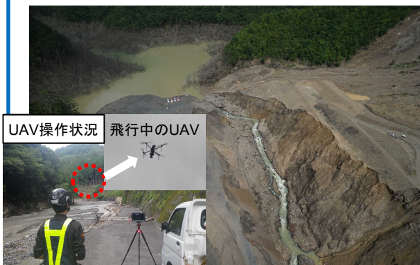
UAVによる現地の状況把握 ※7月18日15時頃撮影
