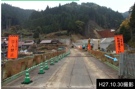
① 溪流保全工 施工状況
