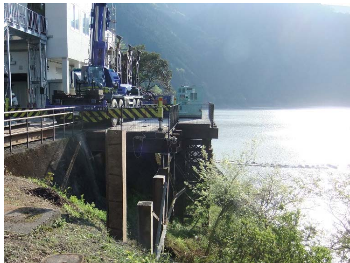
作業用ステージ拡幅状況(杭打設状況) H28.4.20撮影
