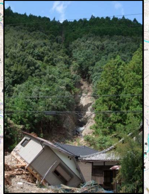
被災状況⑮（新宮市熊野川町九重和田）
