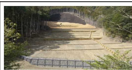
しょうぶだに ③菖蒲谷地区(田辺市本宮町三越) ・崩壊規模 0.90ha ・対策工: 溪間工 山腹工 ※平成26年度完了
