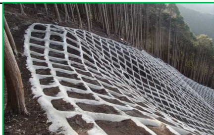
あいごう ①愛賀合地区(田辺市鮎川) ・崩壊規模 0.72ha ・対策工: 溪間工 山腹工
