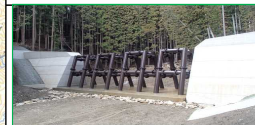
かみへじがわ ⑤上平治川地区(田辺市本宮町皆地) ・崩壊規模 6.26ha ・対策工: 溪間工 山腹工
