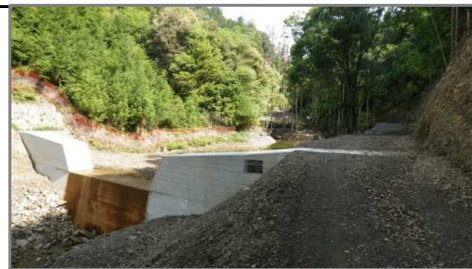
はっしょうまえ ②八升前地区(田辺市本宮町湯峯) ・崩壊規模 0.75ha ・対策工: 溪間工 山腹工
