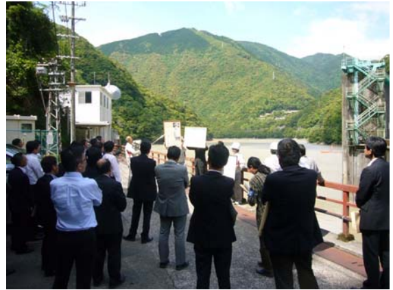
二津野ダムでの状況 (H28.5.18)
