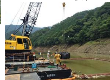
施工状況(H28.9.14)
