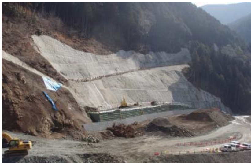
写真-3 工事中(H27)
