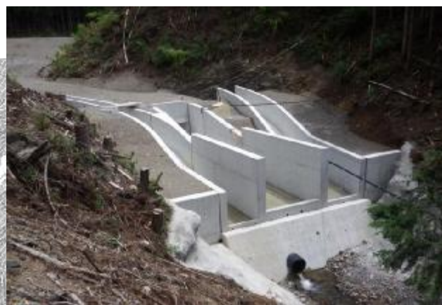
写真② 土捨場 下流土留部 排水減勢工部
