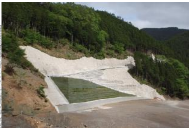
写真① 進入路 起点部
