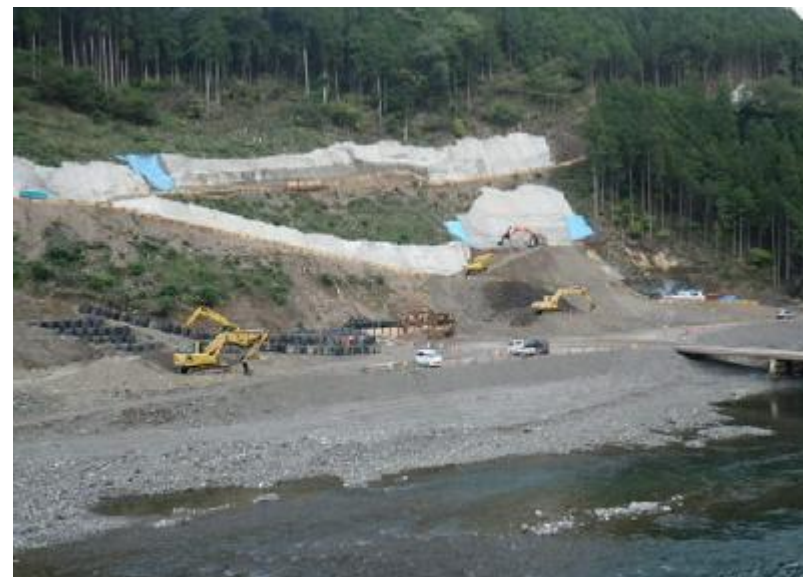
写真-2 工事中(H26)
