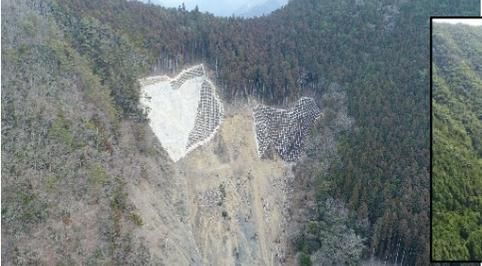
山腹工(簡易法砕吹付工・モルタル吹付工)
