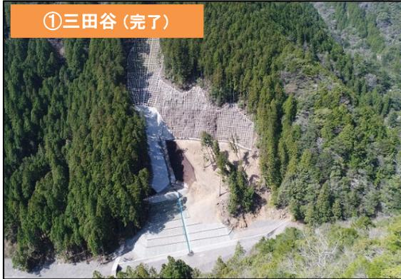
溪間工(鋼製谷止工・コンクリート護岸工)
