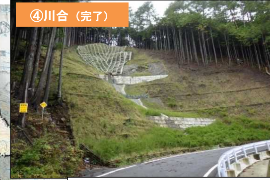
山腹工(土留工・法砕工・緑化工)
