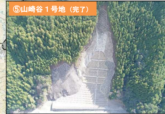
山腹工(法砕工・モルタル吹付工・緑化工) 溪間工(護岸工)
