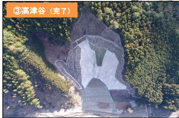
山腹工(法砕工・モルタル吹付工・緑化工) 溪間工(谷止工・護岸工)
