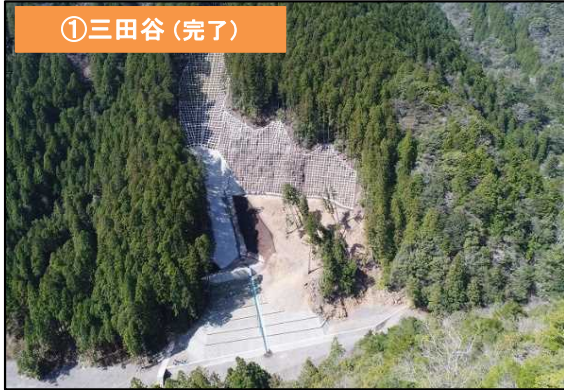
溪間工(鋼製谷止工・コンクリート護岸工) 山腹工(簡易法砕工・モルタル吹付工・コンクリート土留工・緑化工)
