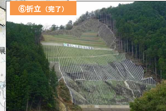
山腹工(法砕工・土留工・緑化工)
