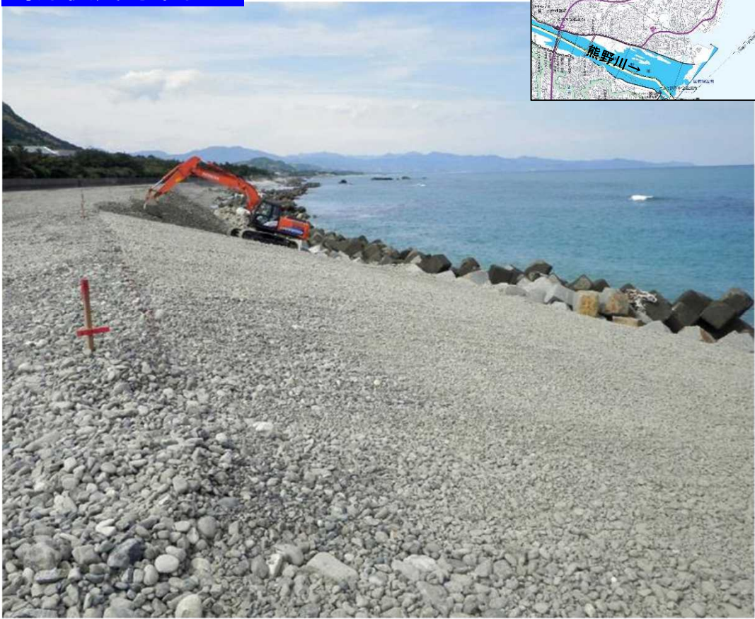
海岸侵食対策状況
