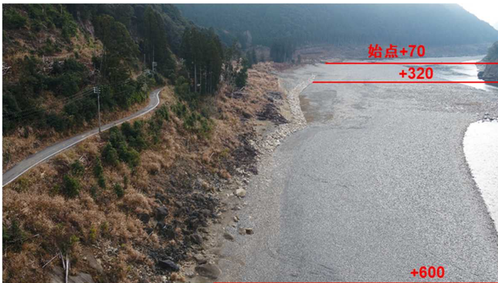
③完成後(上流より撮影)全景 +70~+600付近
