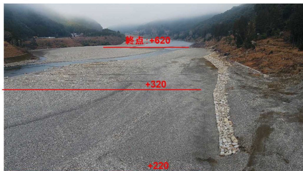
④完成後(下流より撮影)+220~+620
