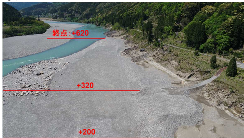
②着手前(下流より撮影)+200~+620
