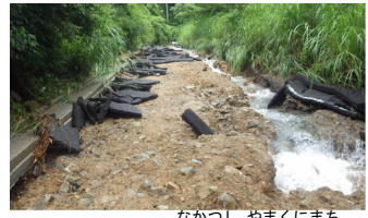
なかつし やまくにまち 7/10 大分県中津市山国町 林道の舗装流出
