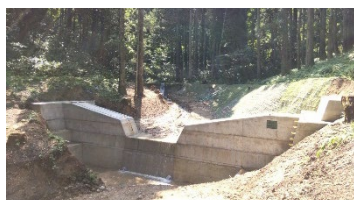
24 砂流出を防止する治山ダム群の整備
