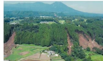
にしもろかたぐん たかはるちょう ひろわら たけやしき 8/9 宮崎県西諸県郡高原町広原竹屋敷 山腹崩壊により家屋や農地等へ土砂流出
