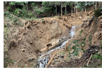
しんしろし しもよした くるぶち 6/2 愛知県新城市下吉田字黒淵 山腹斜面の崩壊、林道の路体流出
