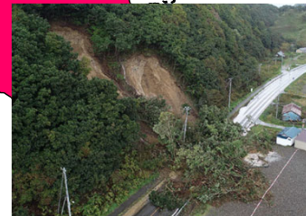
さまにぐんさまにちょう 10/5 北海道様似郡様似町 山腹崩壊により国道へ土砂流出
