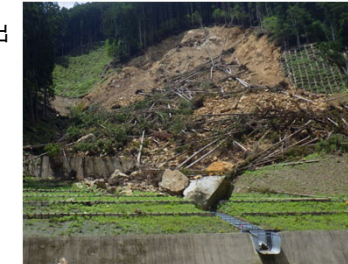
よしのぐん とつかわむら すぎせ 8/15 奈良県吉野郡十津川村杉清 治山施設 (山腹工) の被災
