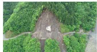
なかぐん なかちょう 6/2 徳島県那賀郡那賀町 林道の法面が崩壊
