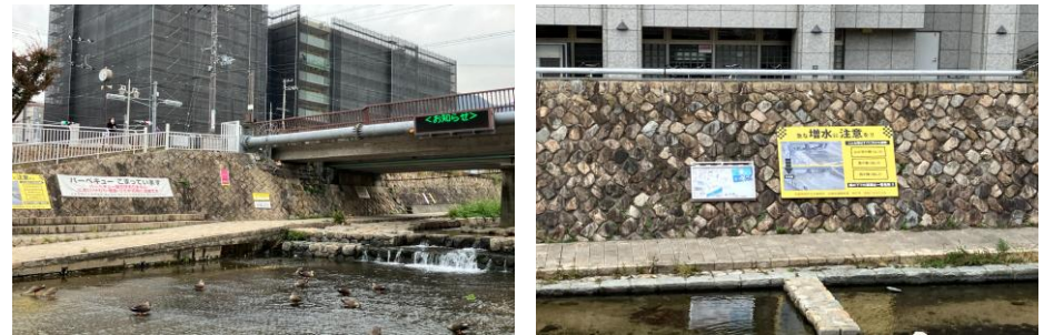
フィールドワーク：都賀川周辺の見学（電光掲示板、急な増水注意の警告看板等）
