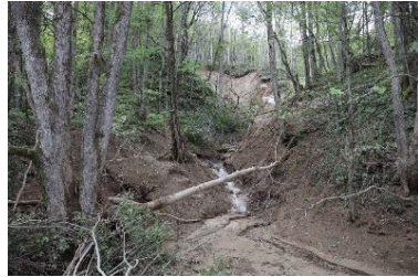
しらぬかぐんしらぬかちょう 9月 北海道白糠郡白糠町 山腹崩壊により道道へ土砂流出
