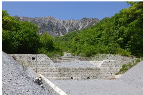
▲【大山国有林（南壁：三ノ沢） 溪間工 施工状況】
