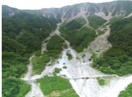
▲【大山国有林（北壁：元谷） 溪間工 施工状況】
