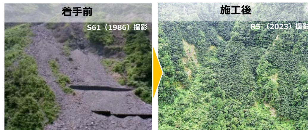
▲【湯の谷中流部：山腹工 (ホ-22) 施工状況】
