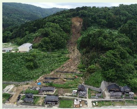
▲【珠洲市 大谷町：倒木・土砂撤去、法枠工・土留工 施工状況】
