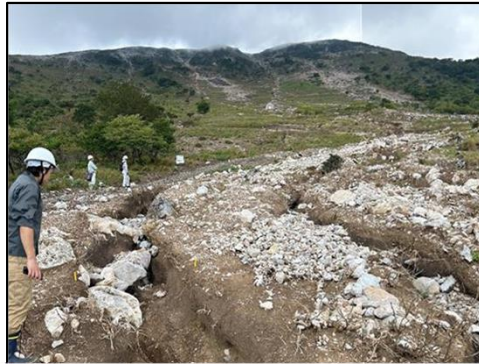
伊吹山被災状況 (R6.9時点)
