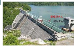
例：幾春別川総合開発事業 新桂沢ダム （桂沢ダムを嵩上げ）
