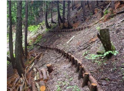
本数調整伐施工後
