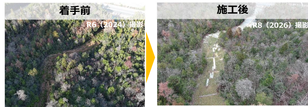
▲【高屋区域：山腹工 施工状況】
