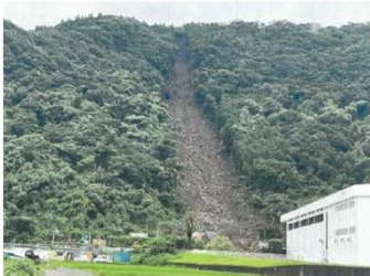
きりしまし 8月 鹿児島県霧島市 山腹崩壊土砂が人家へ流出
