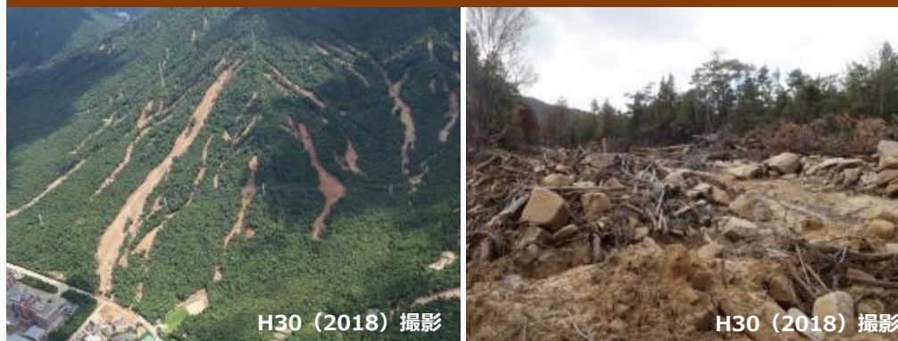
▲【大規模崩壊地】 (黒瀬区域)
