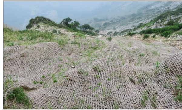
ヤシ繊維ネット伏工 (米原市施工)
