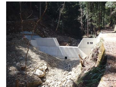
溪間工施工後
