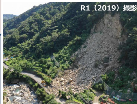
▲ 【R1.7被災の斜面崩壊地】 （上秋津区域）
