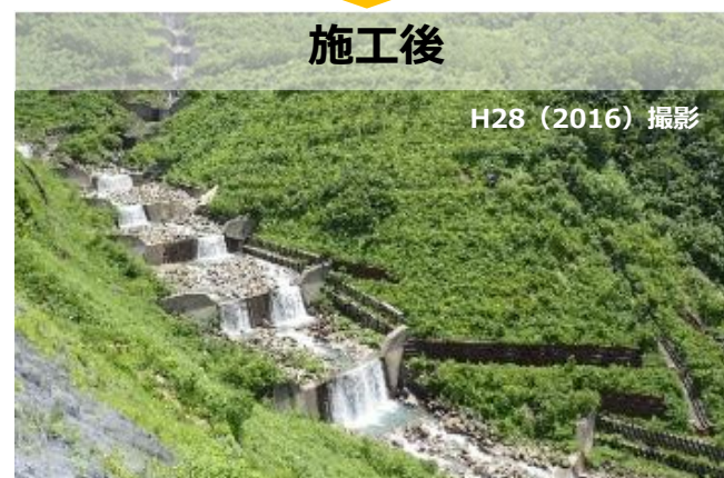
▲【湯の谷上流部：溪間工 (A谷) 施工状況】
