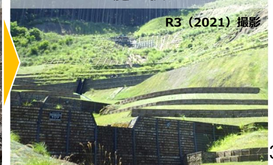
▲ 【本田垣内区域：山腹工・溪間工 施工状況】
