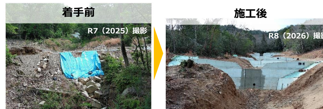
▲【八本松区域：溪間工 施工状況】
