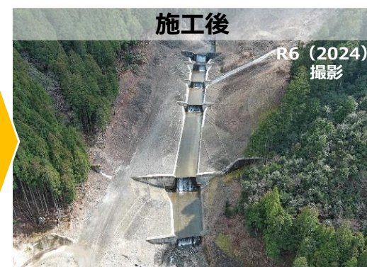
▲【十津川村 神納川区域 五百瀬工区：溪間工 施工状況】
