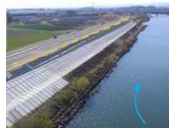
[パイロット施工実施状況]
