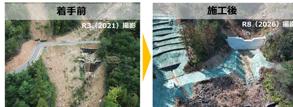
▲【黒瀬区域：溪間工 施工状況】
