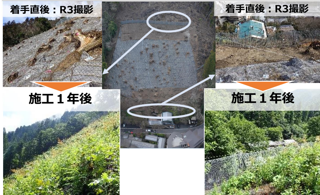
▲【京都市京都市 貴船山国有林：斜面安定対策工施工(経過)状況】 （京都大阪森林管理事務所）
