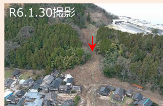
【珠洲市大谷：民家に被害】
