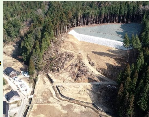
▲【輪島市 興徳寺：倒木・土砂撤去、緑化工・土留工 施工状況】
