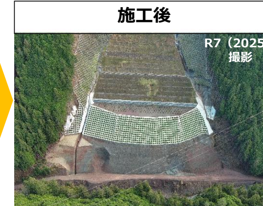
▲【天川村 天川区域 坪内工区：山腹工 施工状況】
