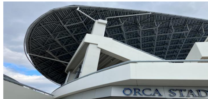
雨樋（オルカスタジアム屋根）
