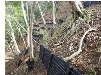
山腹工施工後
