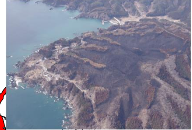
おおふなとし 2月 岩手県大船渡市 広範囲に及ぶ林野火災により森林が焼損
