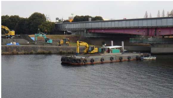
東園田・今在家地区河道掘削（国土交通省）
