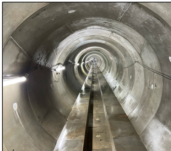
幹線内部の写真
