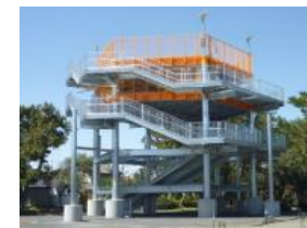
津波避難タワー
