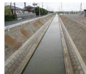
排水路の整備
