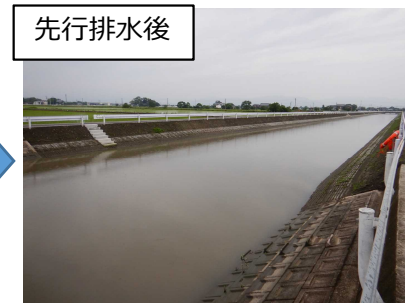
農業水利施設の整備・有効活用(クリークの利用) 【筑後川水系】
