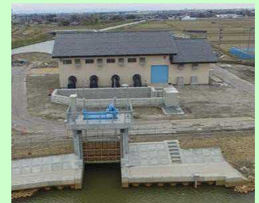
排水機場全景
