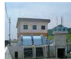
排水機場の整備
