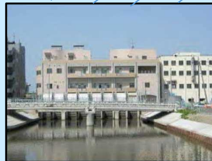
排水機場全景
