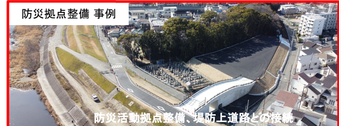
防災活動拠点整備、堤防上道路との接続
