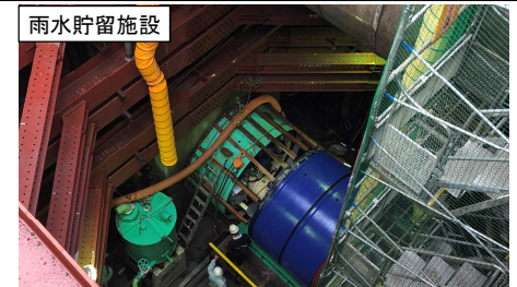
直径3m、延長350mの雨水貯留管整備の掘削立坑(池田市)
