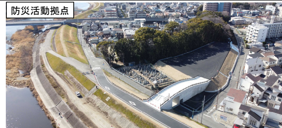
防災活動拠点整備、堤防上道路との接続(国土交通省)
