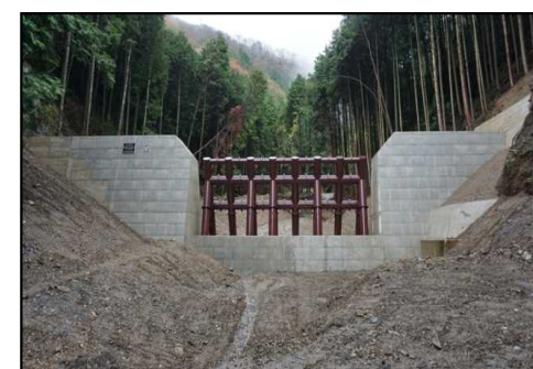
【治山：溪間工(治山ダム)】
