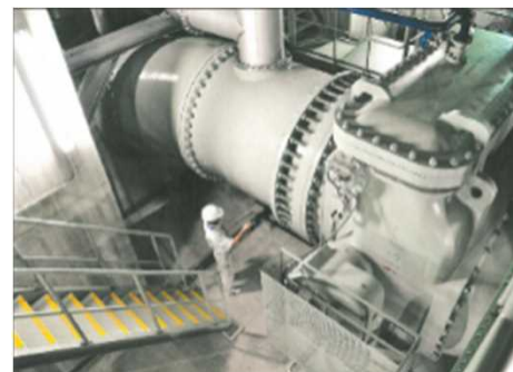
雨水ポンプの整備
