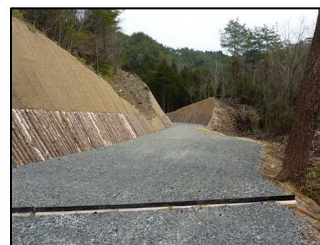
【森林整備：林道(整備)】
