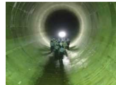
雨水貯留管の整備
