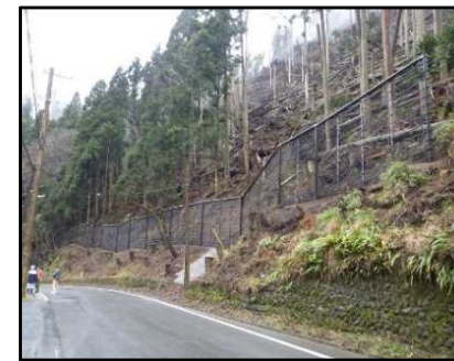
【落石防護柵の設置】
