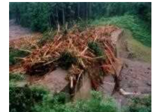
流木捕捉式治山ダム
