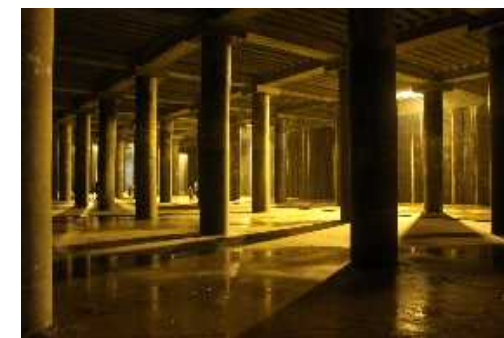
貯留施設の整備
