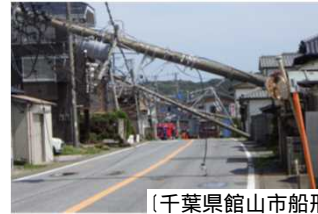
【台風等による電柱倒壊状況】
