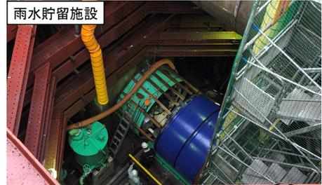
直径3m、延長350mの雨水貯留管整備の掘削立坑（伊丹市）
