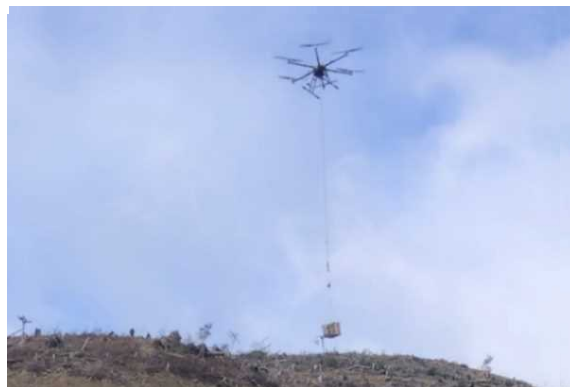
ドローンによる資材運搬
