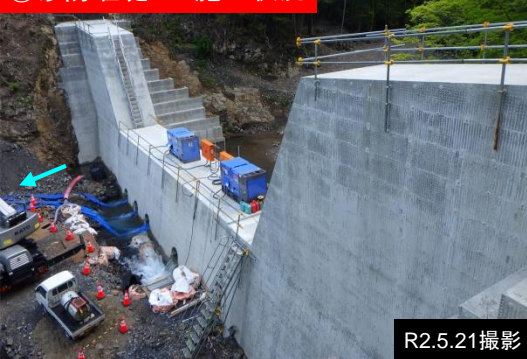
②砂防堰堤工 施工状況
