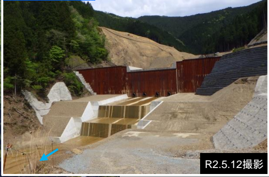
③砂防堰堤工
