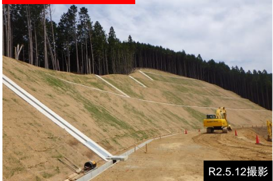
①排土工 施工状況
