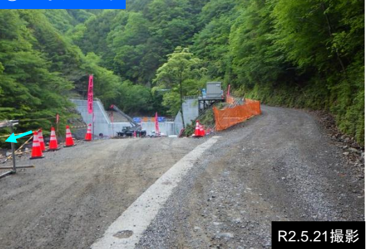
①工事用道路
