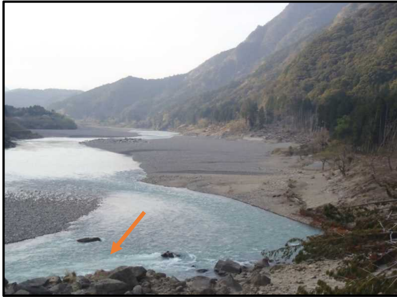
②現在の状況 上流端部(下流側から撮影)
