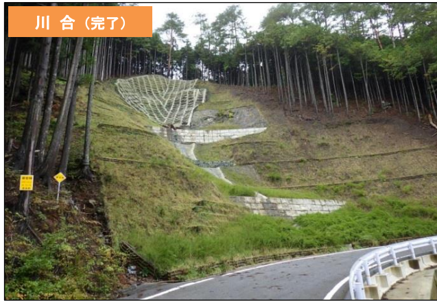
山腹工(土留工・法枠工・緑化工)
