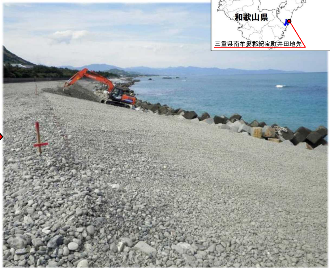
海岸侵食対策状況
