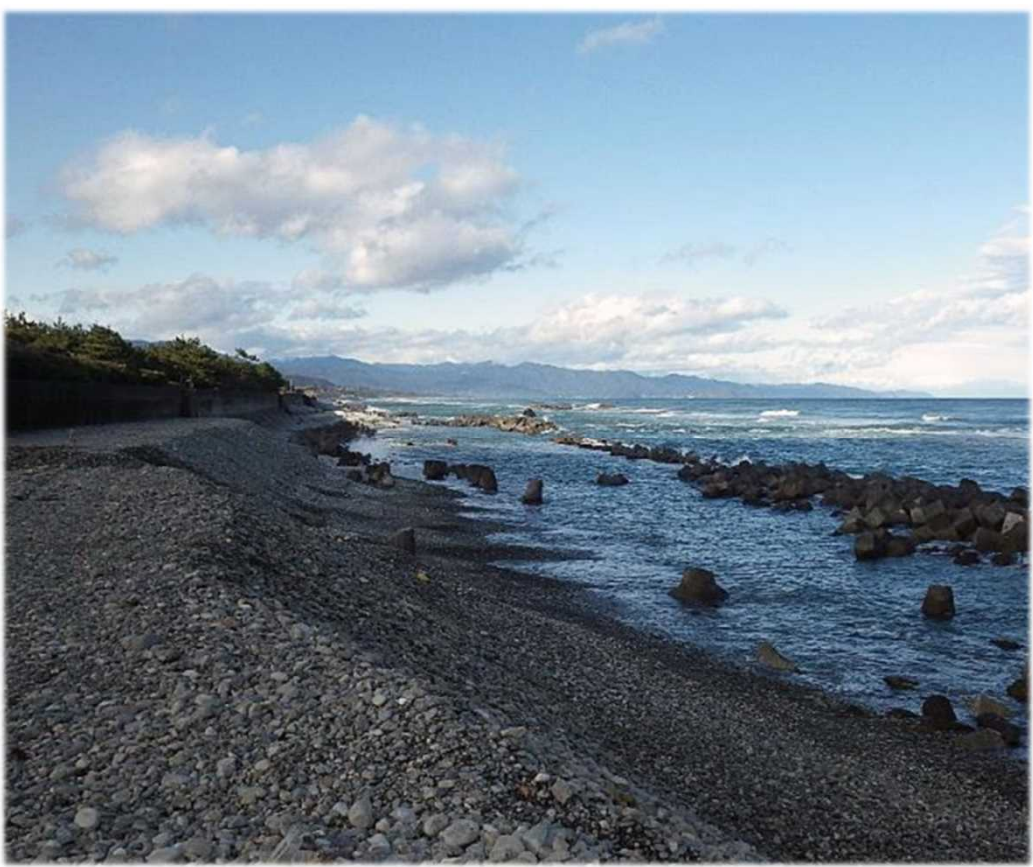
海岸侵食対策前
