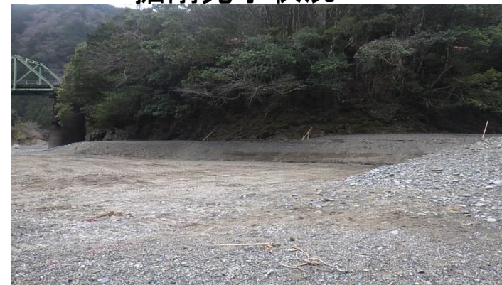
掘削完了状況
