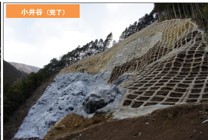
山腹工(法枠工・モルタル吹付工・緑化工)
