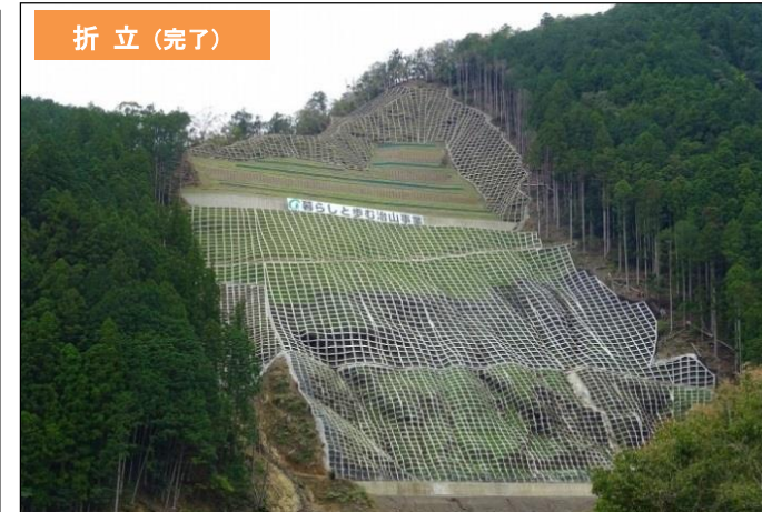
山腹工(法枠工・土留工・緑化工)
