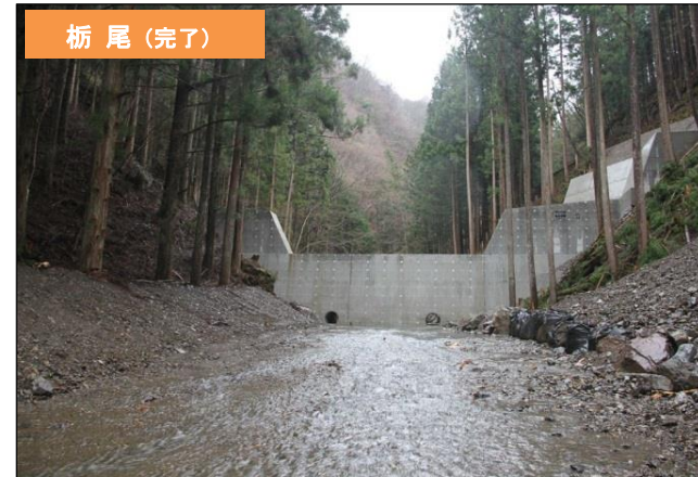
溪間工(谷止工)
