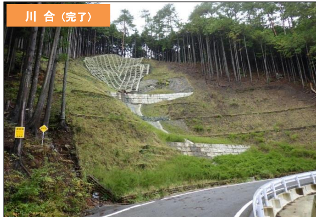
山腹工(土留工・法枠工・緑化工)
