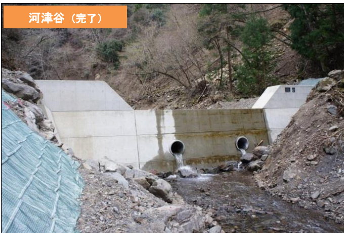
溪間工(谷止工)
