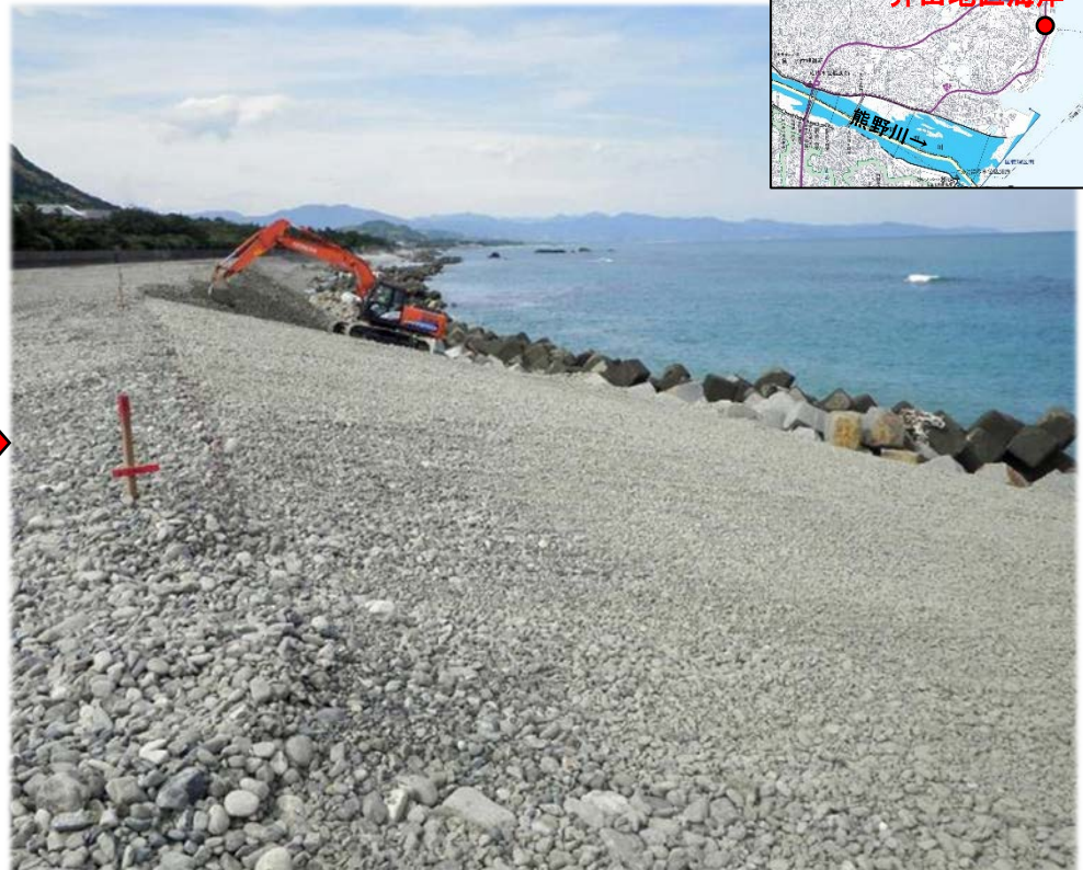
海岸侵食対策状況
