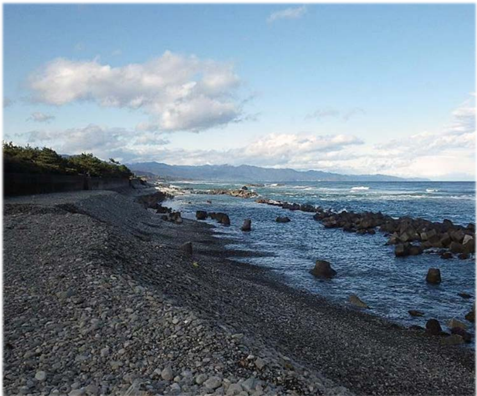
海岸侵食対策前
