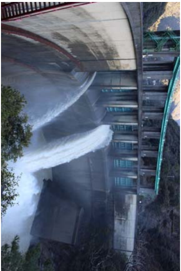
ゲート放流状況
