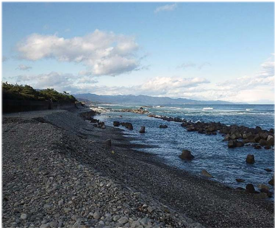
海岸侵食対策前
