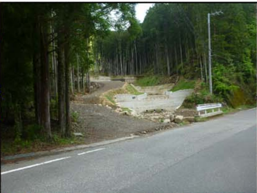
完成状況（新宮市熊野川町赤木赤木谷）
