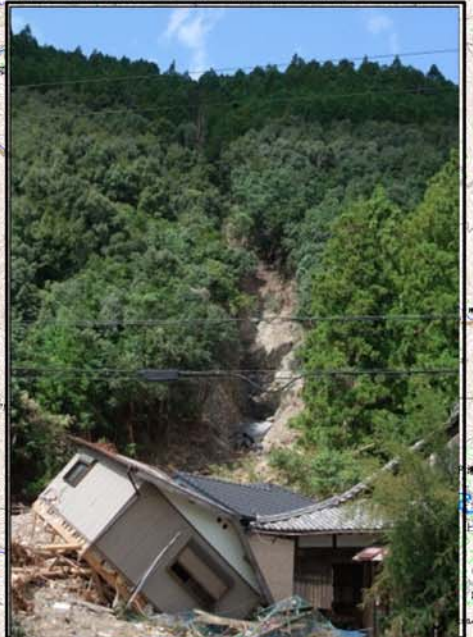
被災状況（新宮市熊野川町九重和田）
