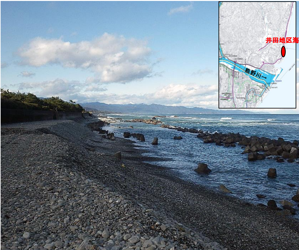
海岸侵食対策前
