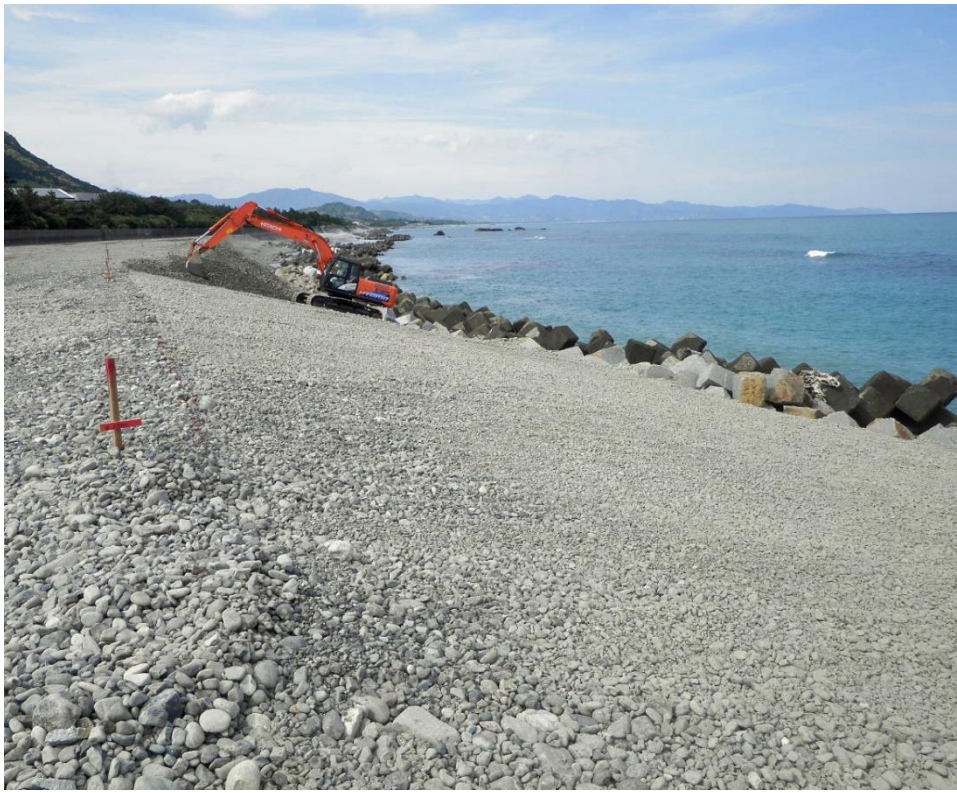
海岸侵食対策状況
