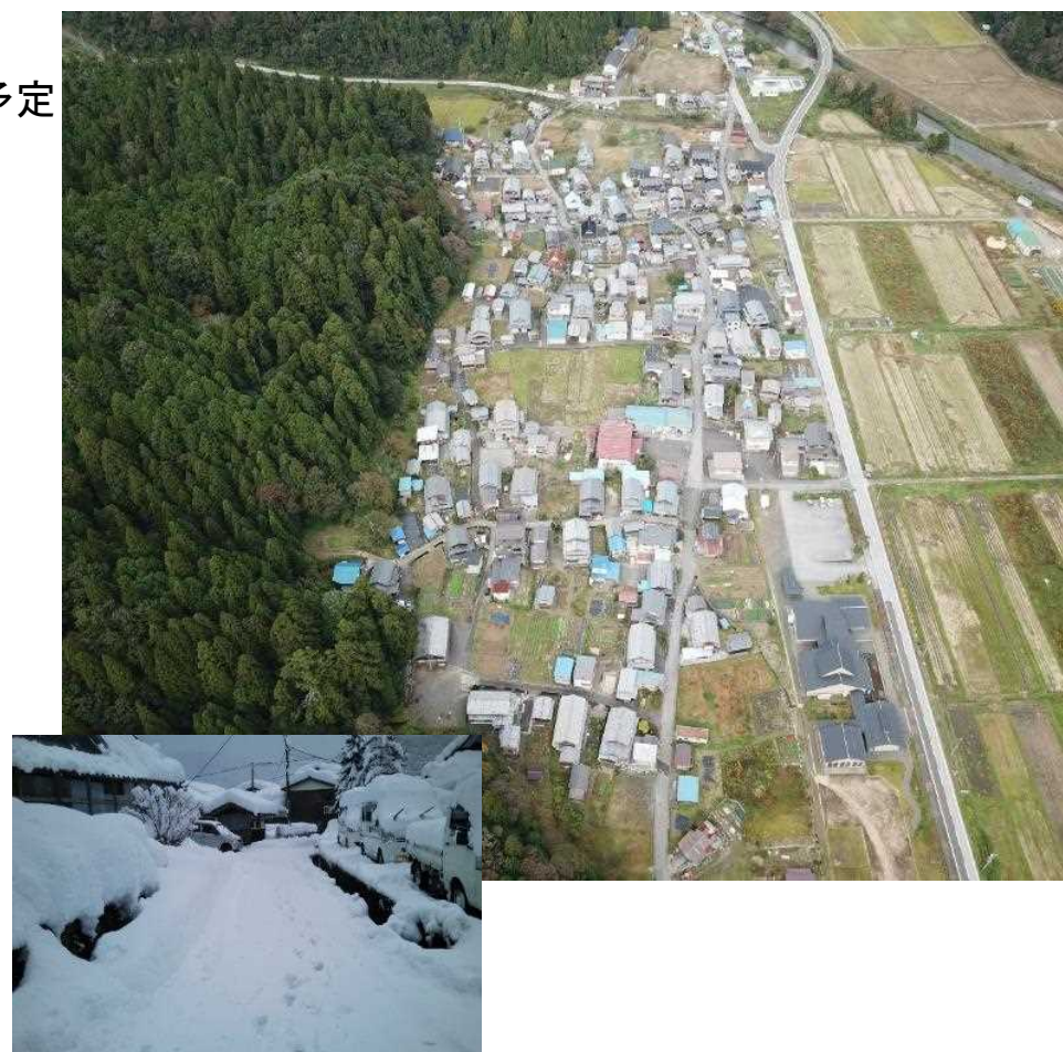
消雪施設整備
