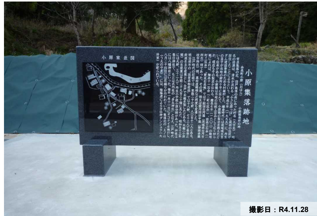
小原地区石碑設置状況
