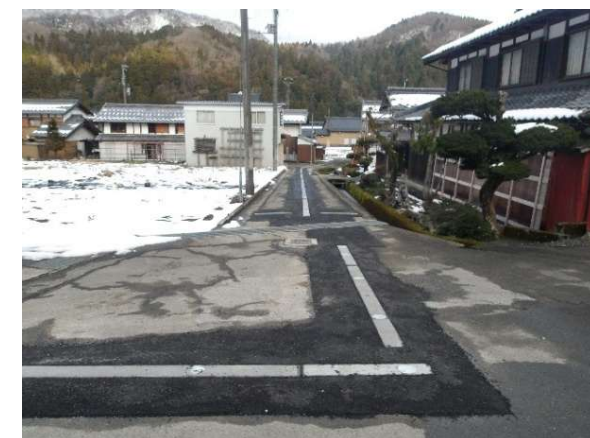
消雪管布設(実施中)
