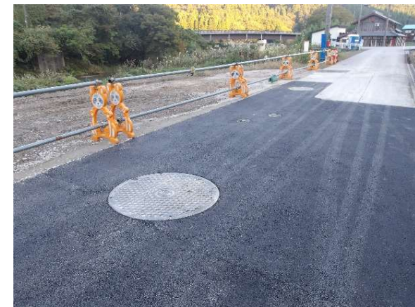
集水井整備(完成)
